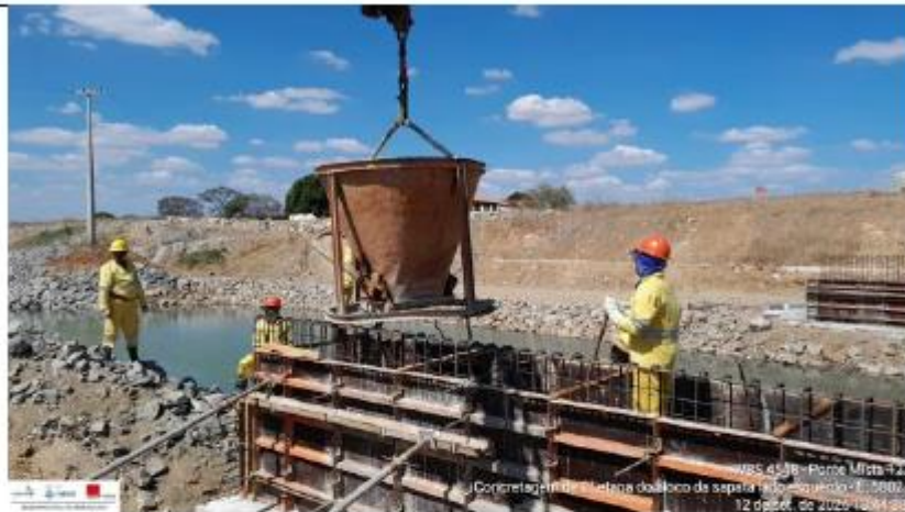
Foto 35: concretagem do bloco da sapata
