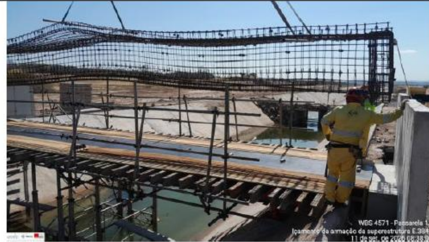
Foto 8: içamento da armação
