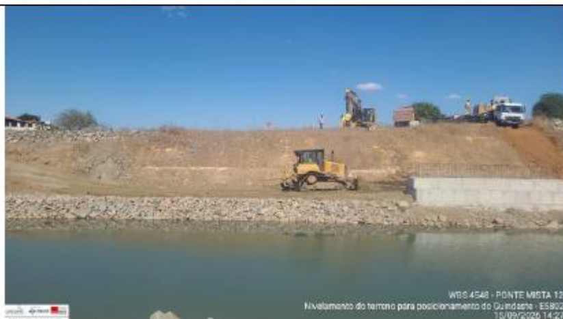
Foto 37: nivelamento do terreno
