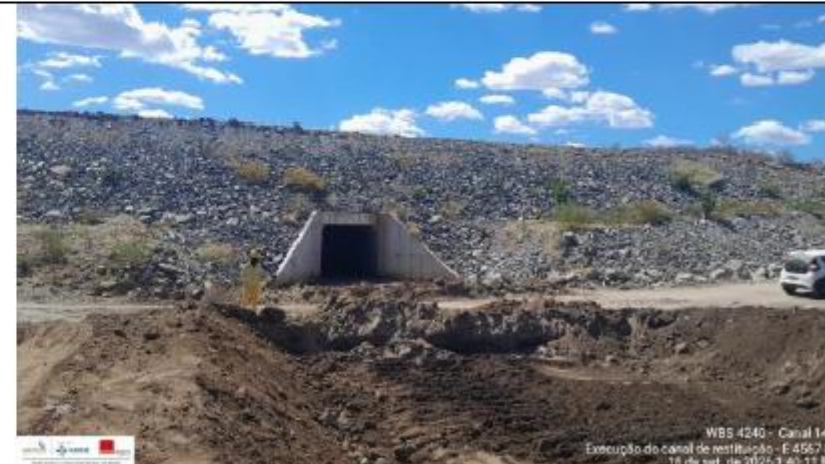
Foto 14: Execução do canal de restituição
