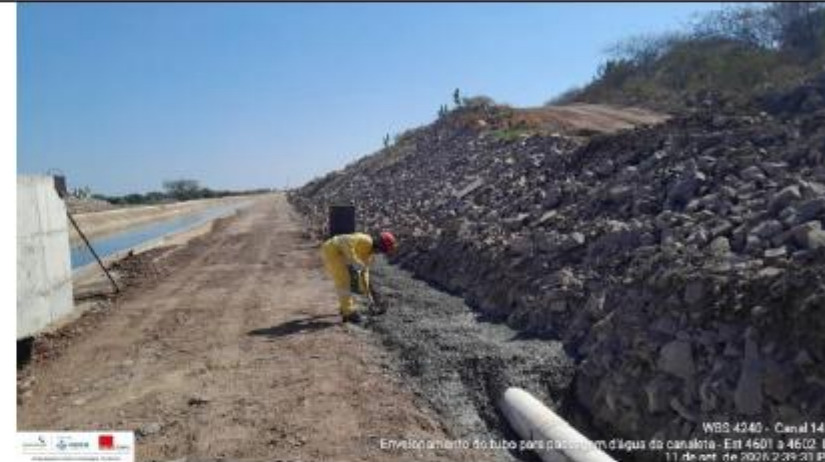
Foto 12: envelopamento de tubo da canaleta
