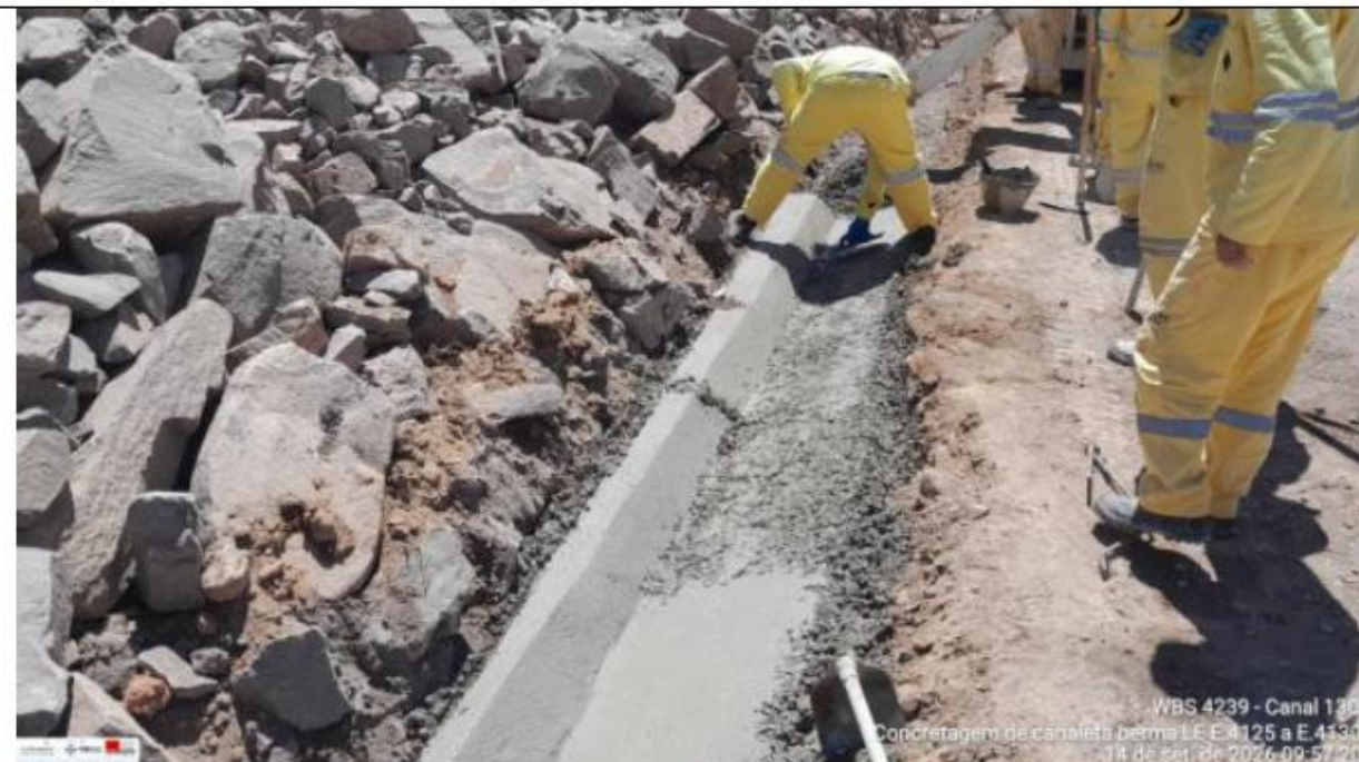
Foto 6: concretagem de canaleta berma
