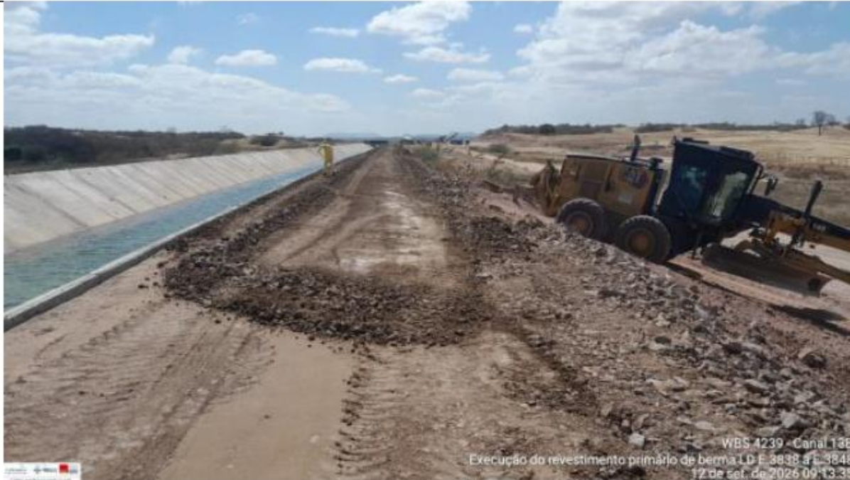
Foto 3: revestimento primário de berma e canaletas
