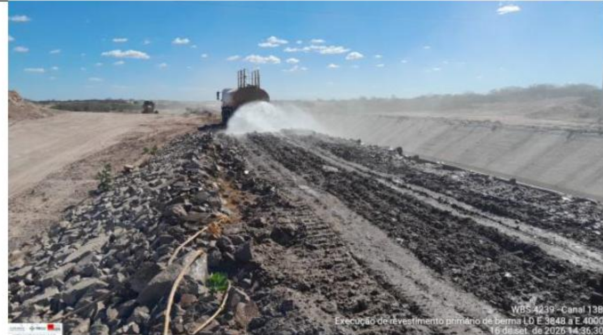
Foto 4: revestimento primário de berma e canaletas
