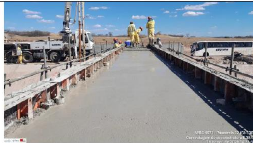
Foto 10: concretagem da superestrutura
