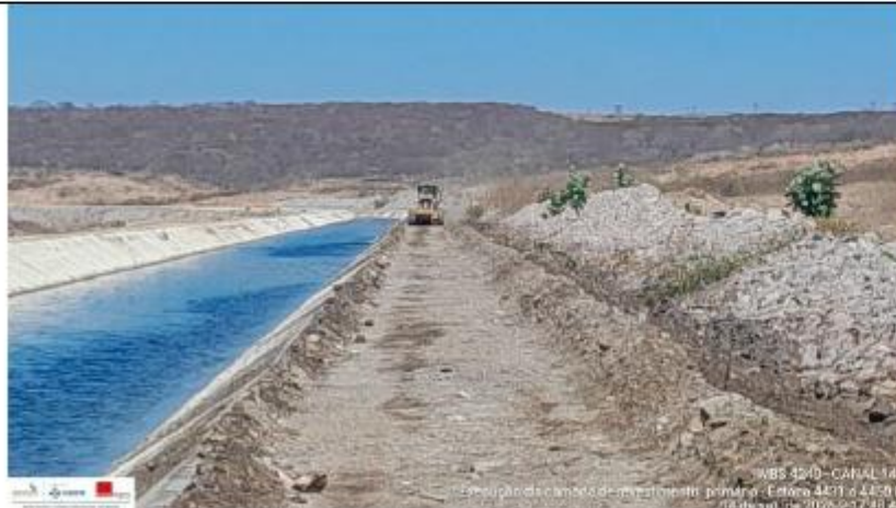
Foto 13: revestimento primário da berma LE
