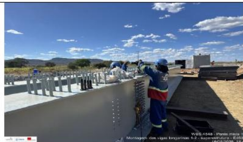
Foto 38: Montagem das vigas longarinas
