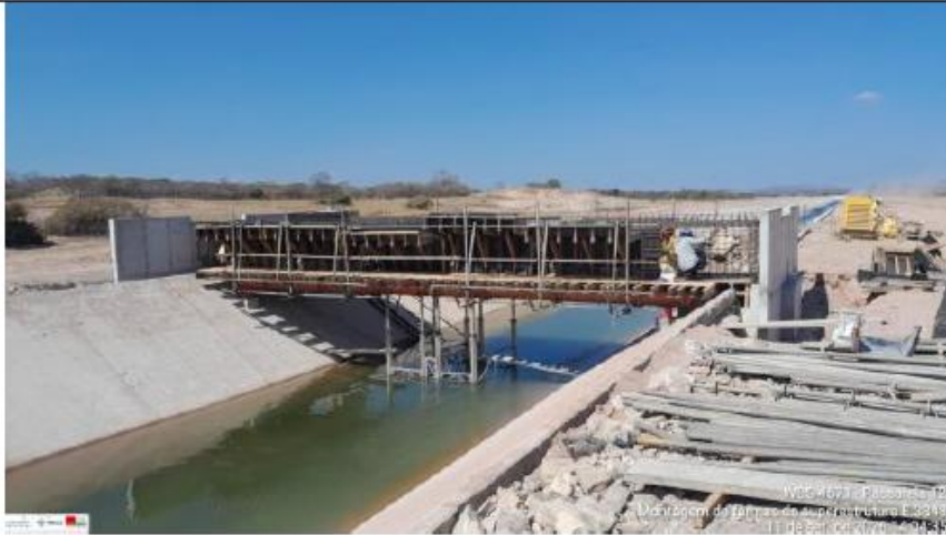
Foto 7: execução da superestrutura
