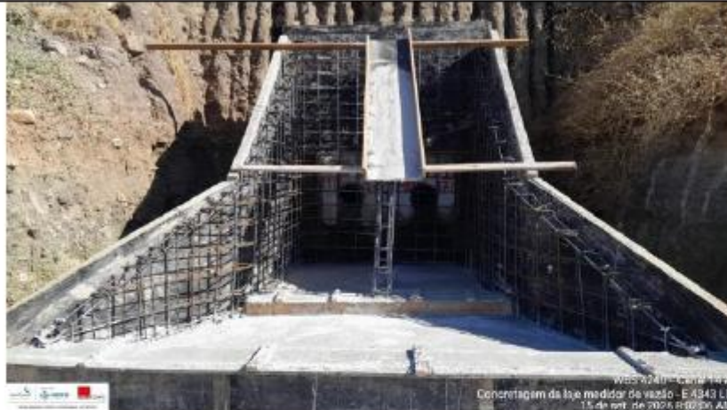
Foto 11: concretagem do medidor de vazão
