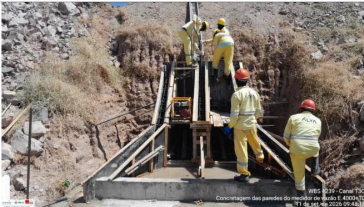
Foto 5: concretagem do medidor de vazão
