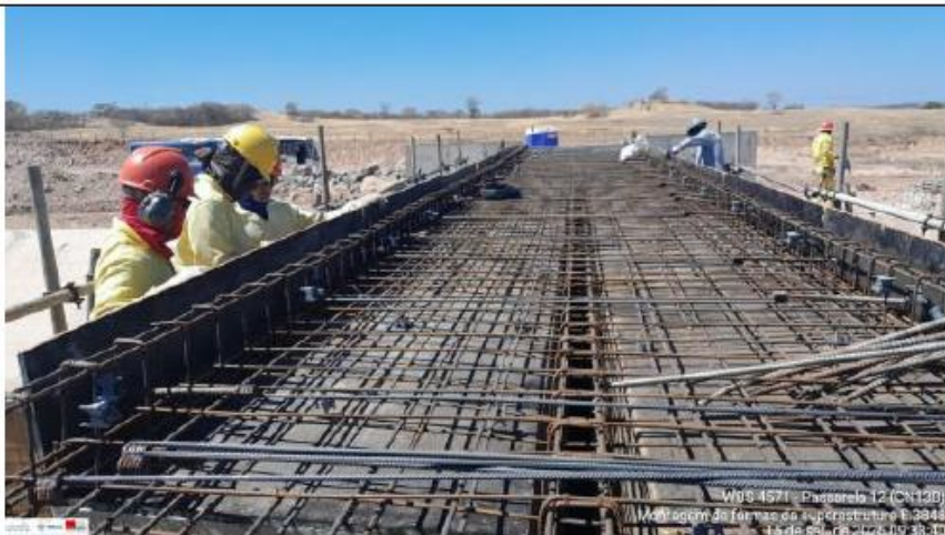
Foto 9: montagem das fôrmas
