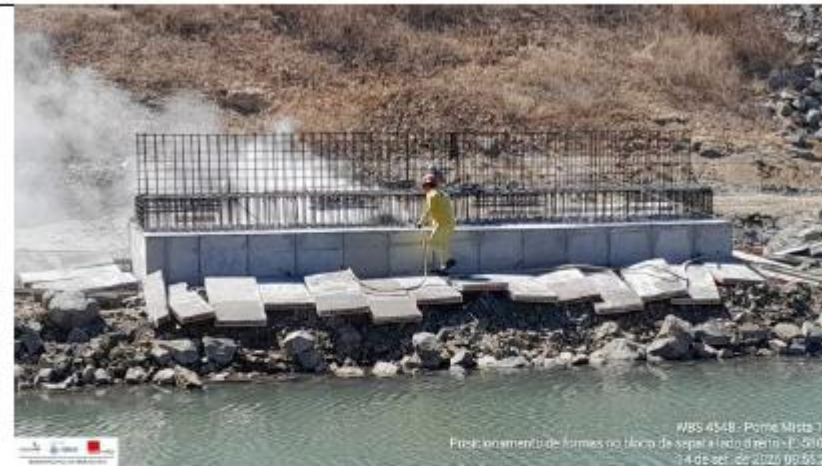
Foto 36: Posicionamento das formas
