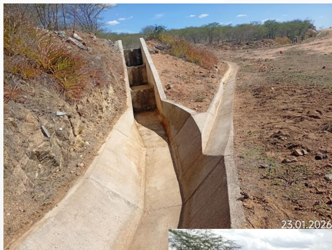
Limpeza da drenagem no Canal C6
