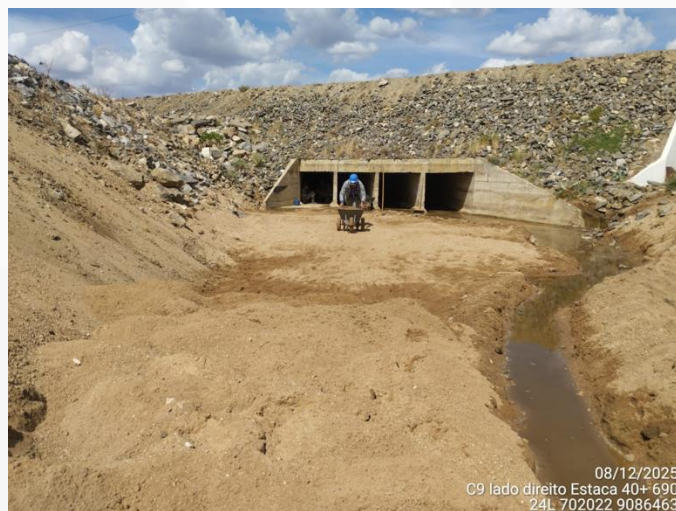
Limpeza externa dos bueiros B17 e B43
