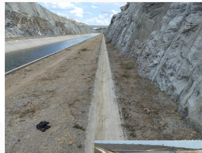
Limpeza da vegetação no Canal C9
