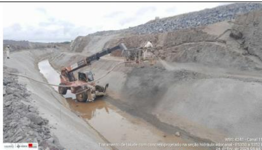
Foto 42: revestimento dos taludes de canal
