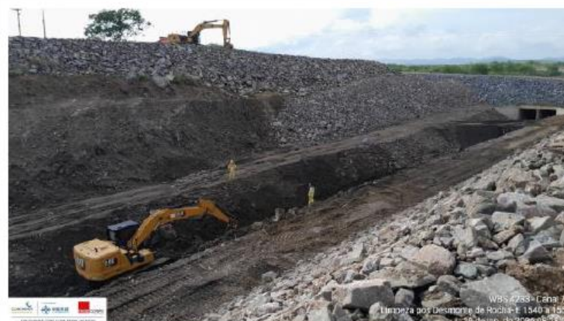
Foto 4: enrocamento de proteção externa do talude
