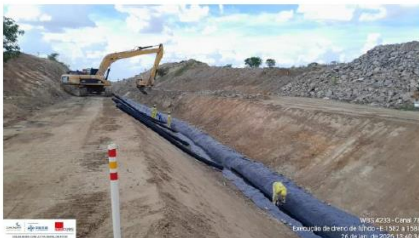
Foto 1: execução do dreno de fundo
