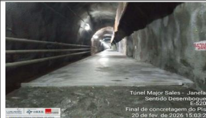
Foto 35: concretagem do piso
