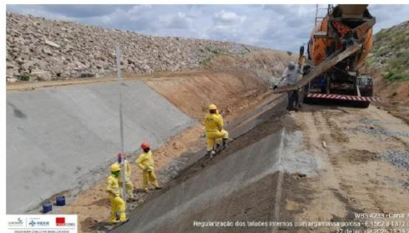
Foto 2: regularização interna de talude
