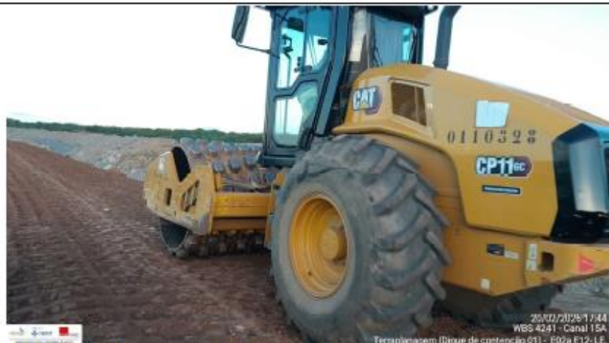
Foto 39: execução de aterro
