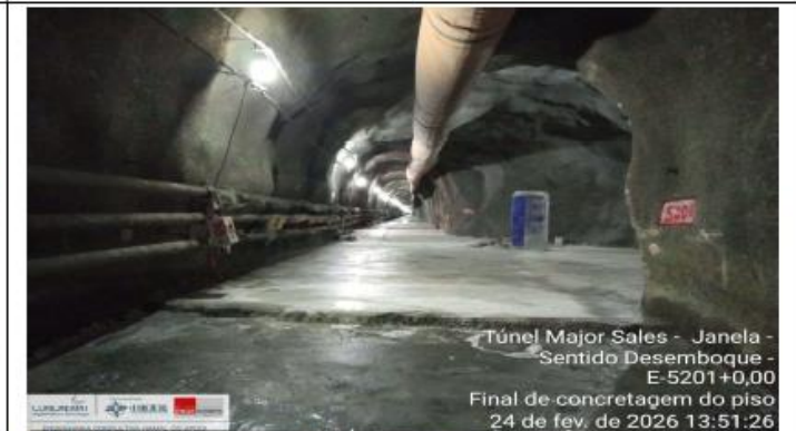
Foto 36: concretagem do piso
