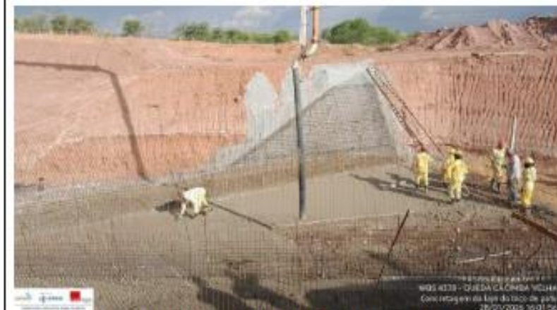
Foto 22: concretagem da laje do bico de pato
