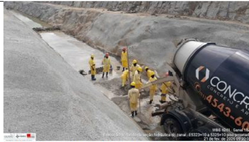
Foto 40: revestimento de piso de canal
