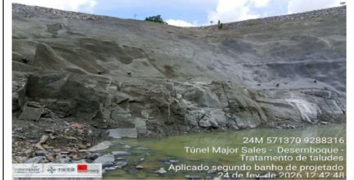
Foto 34: tratamento de taludes
