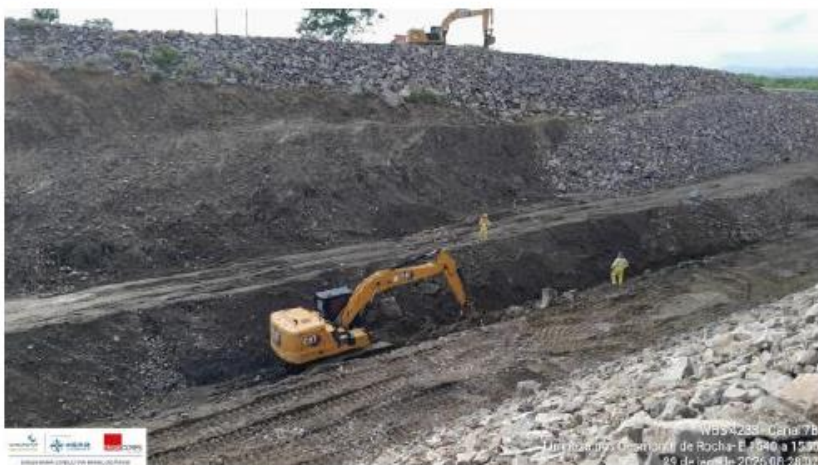
Foto 3: limpeza após desmonte de rocha
