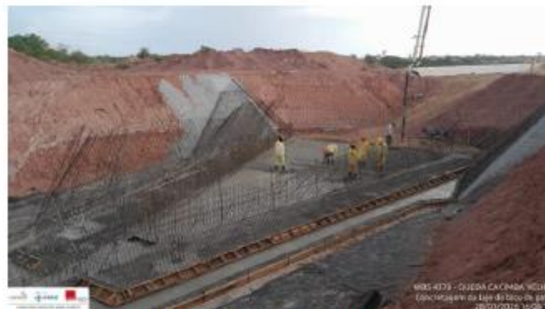
Foto 21: concretagem da laje
