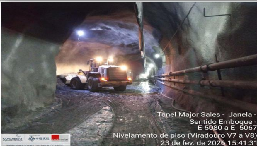
Foto 37: nivelamento do piso
