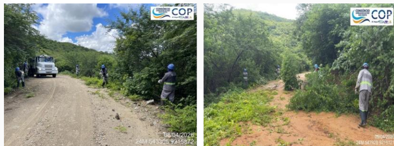
Limpeza e desobstrução do canal de restituição do MV no Res. Porcos
