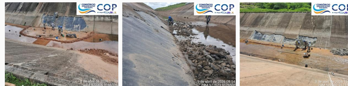
Intervenção e reparo de canal adutor WBS 1214, 1229 e 1230
