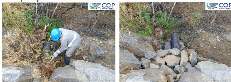
Manutenção de drenagem de jusante próximo ao poço de alívio no Res. Terra Nova
