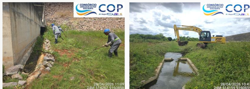
Manutenção de drenagem de jusante próximo ao poço de alívio no Res. Terra Nova
