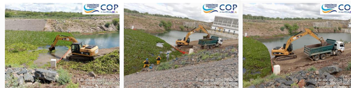
Retirada de vegetação aquática no forebay de montante da EBI-1
