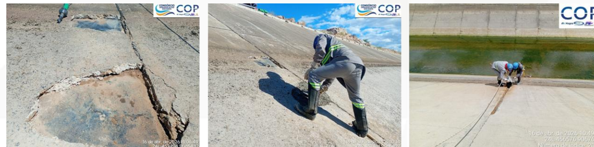
Reparo de placas danificadas nos canais CN02 e CN03
