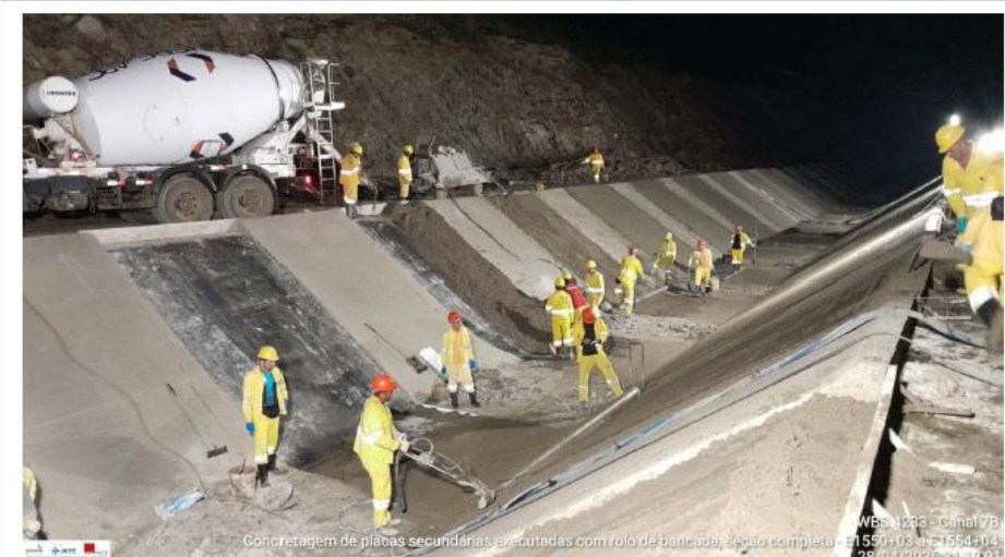
Foto 4: revestimento de canal
