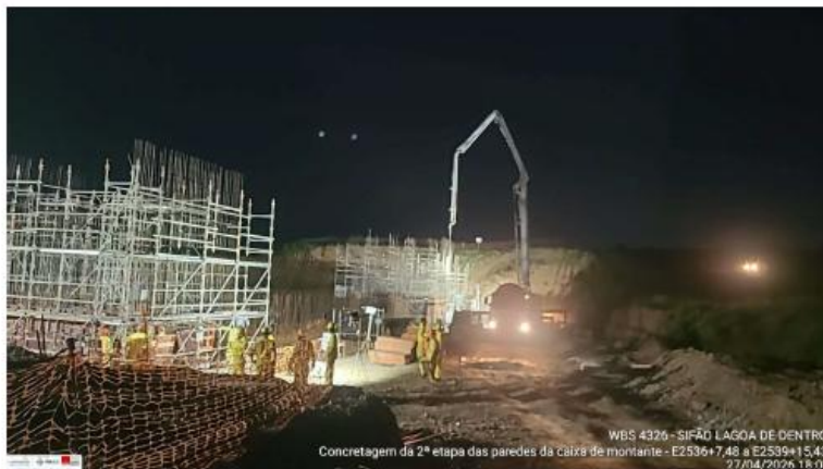
Foto 9: concretagem da 2ª etapa das paredes da caixa de montante
