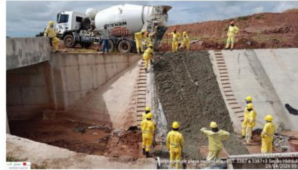
Foto 18: revestimento de canal
