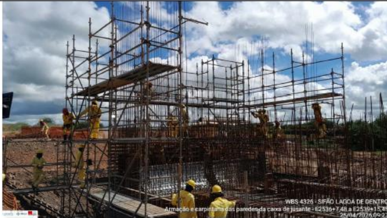
Foto 7: armação e carpintaria das paredes da caixa jusante
