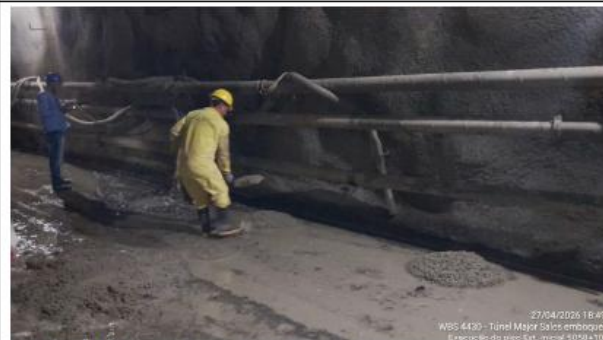
Foto 47: execução do piso
