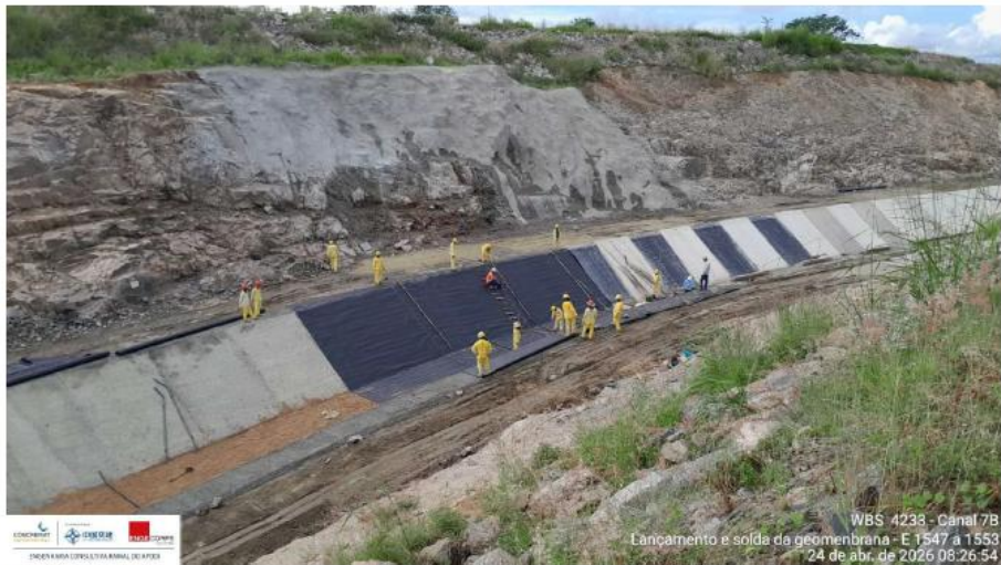
Foto 1: avanço de geomembrana
