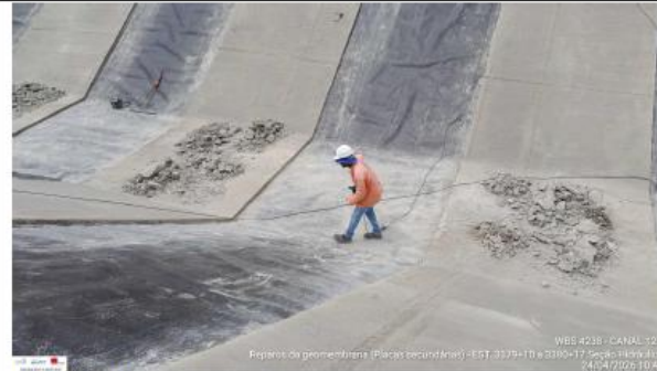
Foto 15: execução de geomembrana
