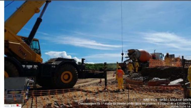
Foto 8: concretagem da 1ª etapa da parede J4 da caixa de jusante
