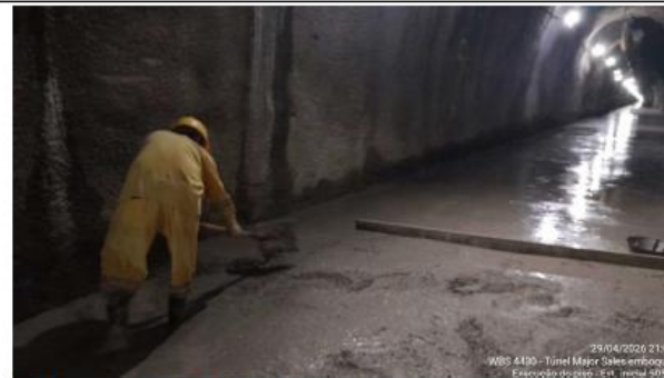
Foto 48: execução do piso
