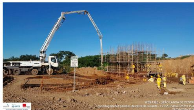
Foto 10: concretagem das paredes da caixa de jusante
