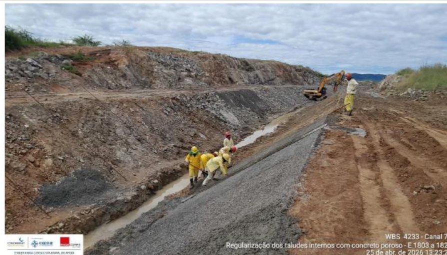
Foto 3: regularização interna de talude
