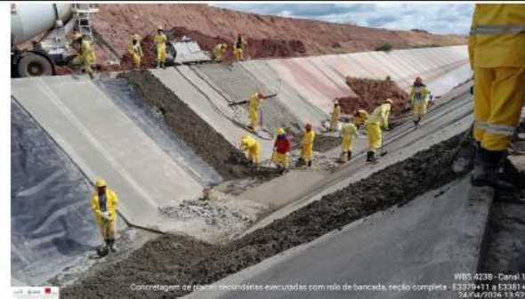
Foto 16: revestimento de canal
