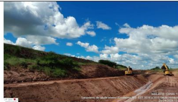
Foto 20: conformação de talude interno
