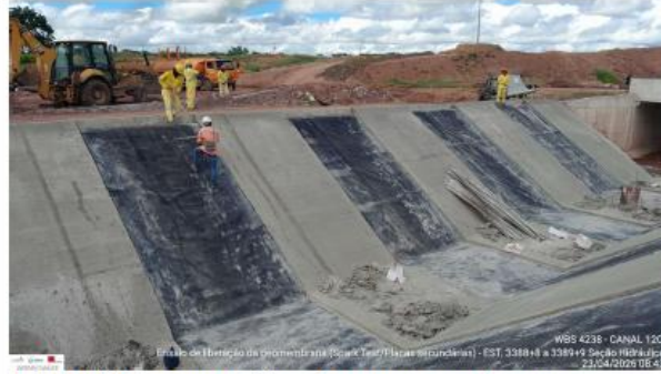
Foto 17: execução de geomembrana
