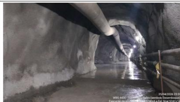
Foto 51: execução do piso
