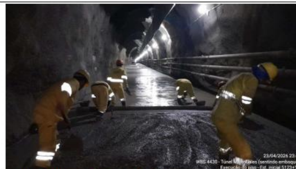
Foto 50: execução do piso
