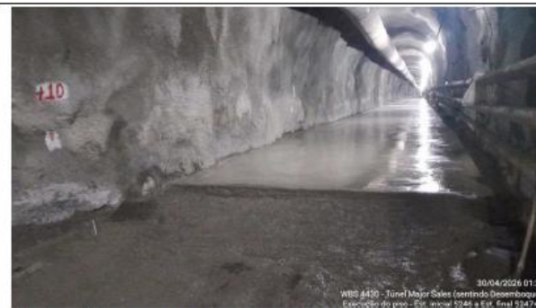
Foto 52: execução do piso
