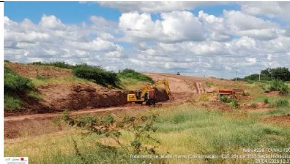
Foto 19: conformação de talude interno
