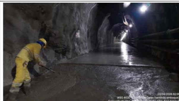
Foto 49: execução do piso
