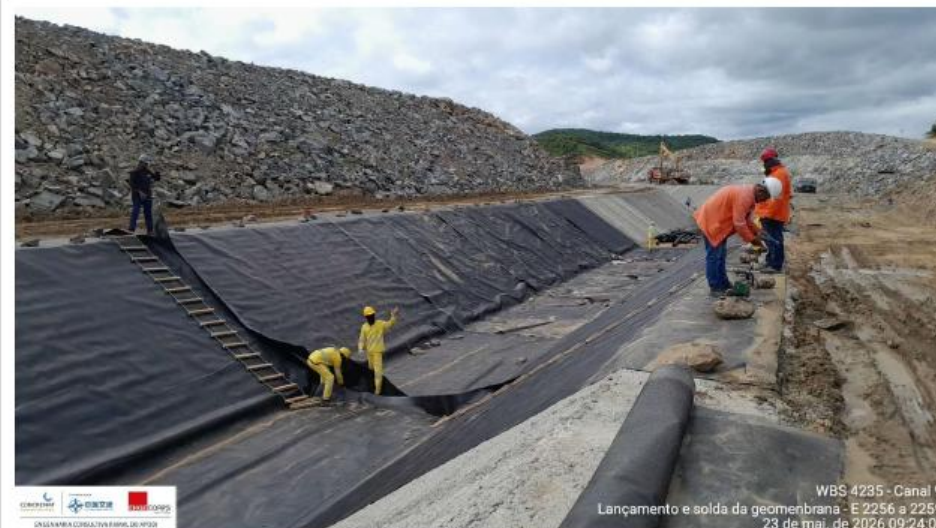
Foto 6: avanço de geomembrana
