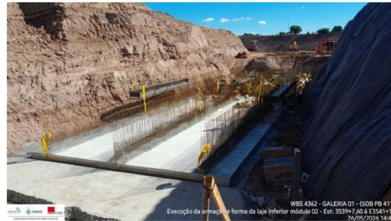
Foto 22: armação e forma da laje inferior do módulo 02
