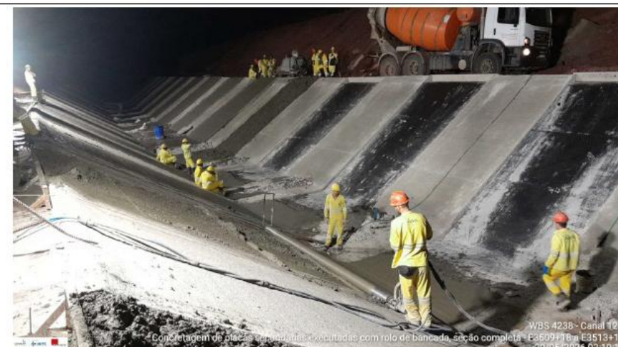
Foto 20: revestimento de canal
