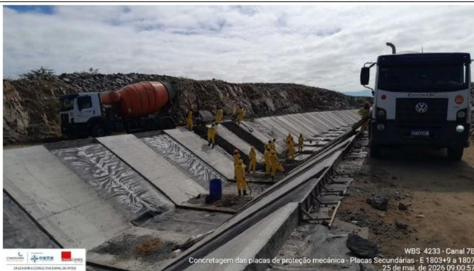
Foto 3: revestimento de canal
