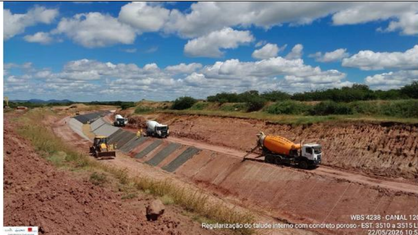
Foto 17: regularização interna de talude
