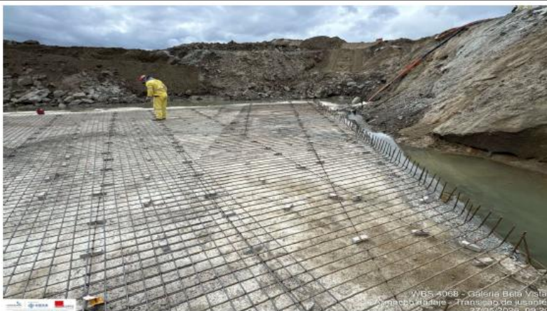
Foto 49: armação da laje de transição jusante
