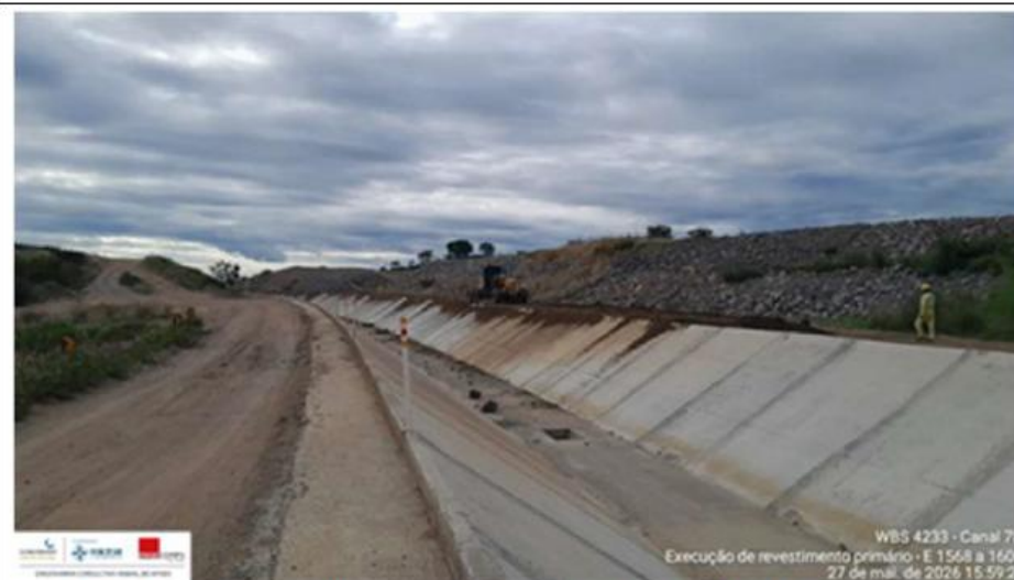
Foto 4: revestimento primário de berma
