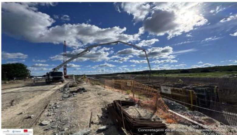
Foto 47: concretagem da 2ª etapa das paredes do módulo 2.9
