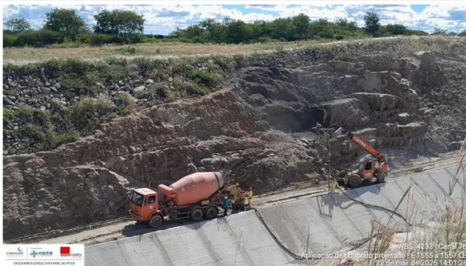
Foto 1: tratamento de taludes
