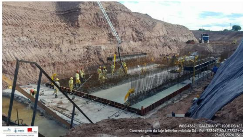
Foto 21: concretagem da laje inferior do módulo 04
