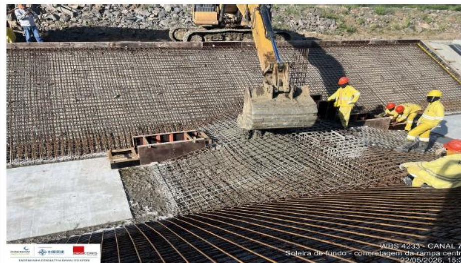
Foto 2: concretagem da rampa central
