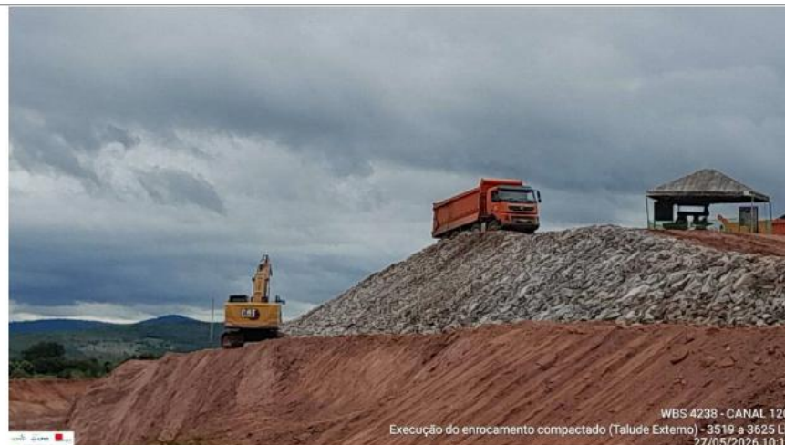
Foto 19: enrocamento de talude externo
