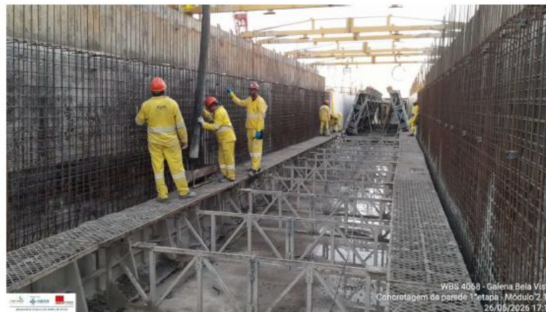
Foto 48: concretagem da 1ª etapa das paredes do módulo 2.10
