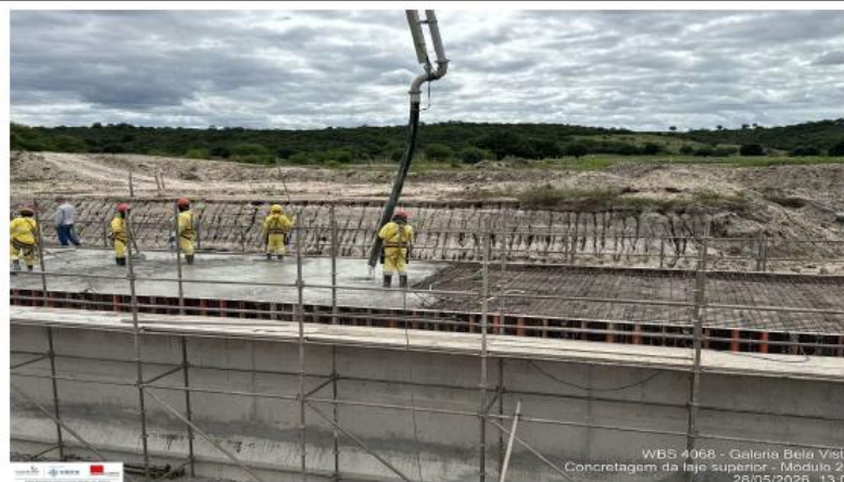
Foto 50: concretagem da laje superior do módulo 2.7
