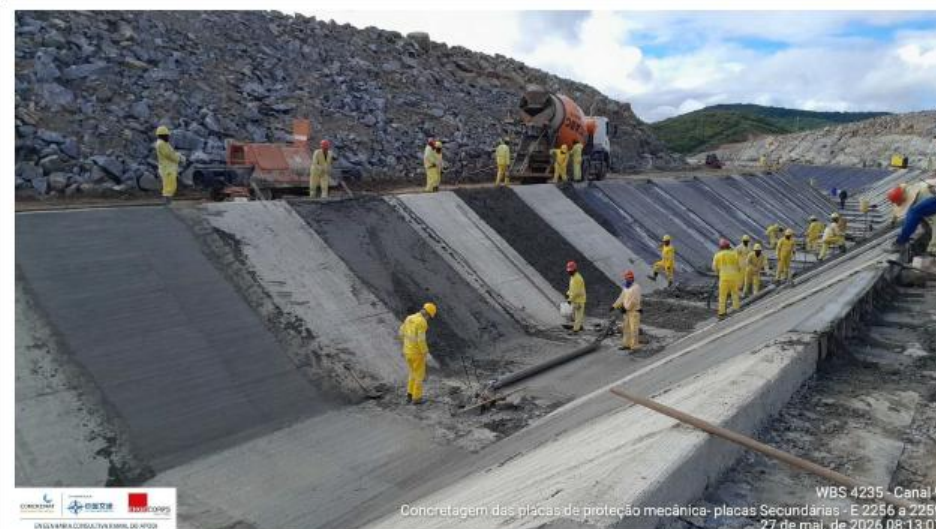
Foto 8: revestimento de canal
