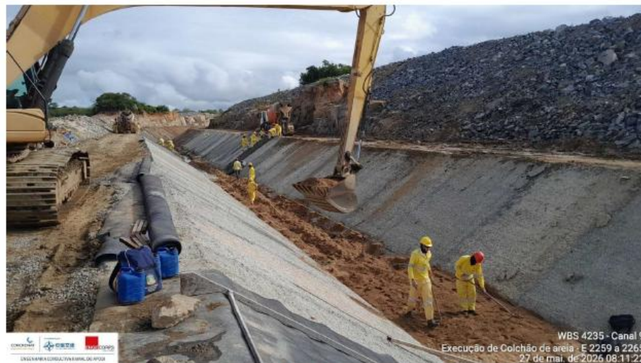
Foto 7: execução de drenagem interna
