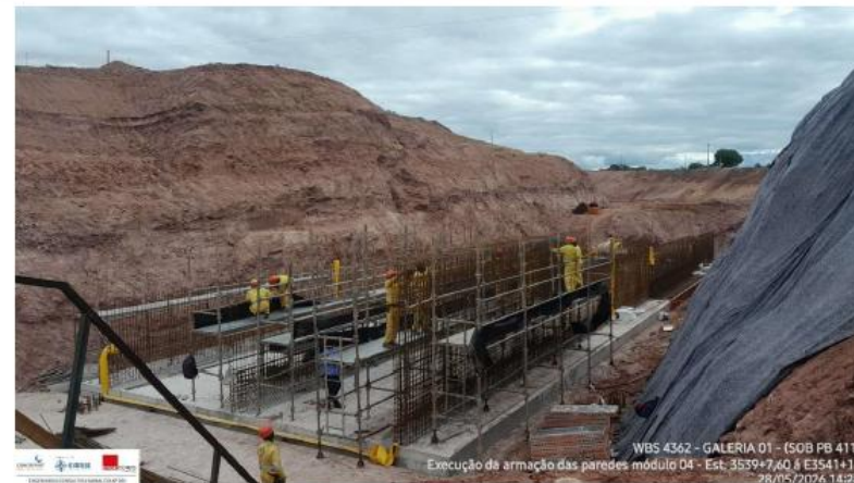
Foto 24: armação das paredes do módulo 04
