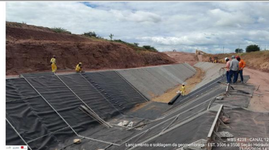
Foto 18: avanço de geomembrana
