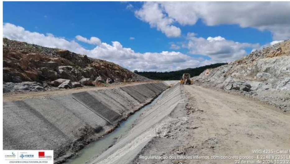
Foto 5: regularização interna de talude
