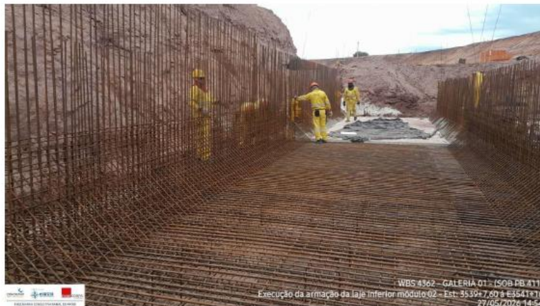
Foto 23: armação da laje inferior do módulo 02
