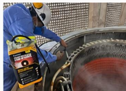
Limpeza química dos enrolamentos do estator
