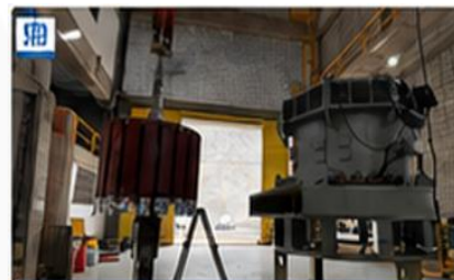
Desmontagem do motor
