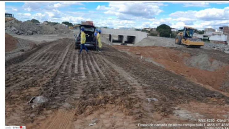
Foto 46: execução de aterro
