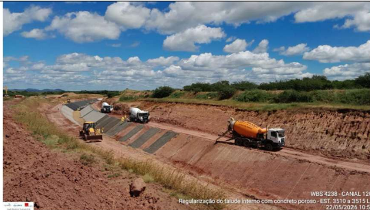
Foto 17: regularização interna de talude
