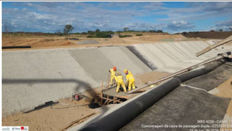
Foto 11: concretagem da caixa de passagem
