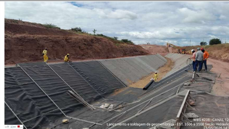
Foto 18: avanço de geomembrana
