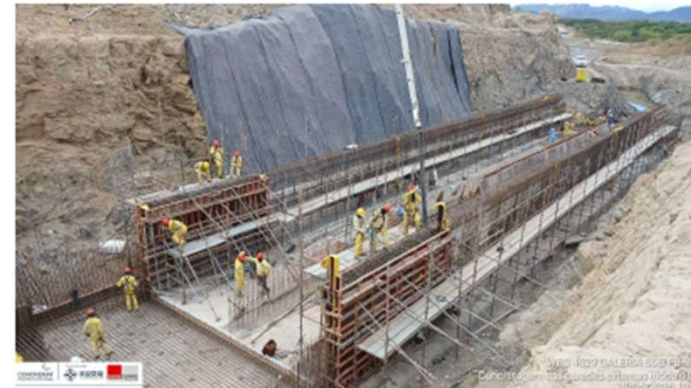
Foto 60: concretagem das paredes externas do módulo 01
