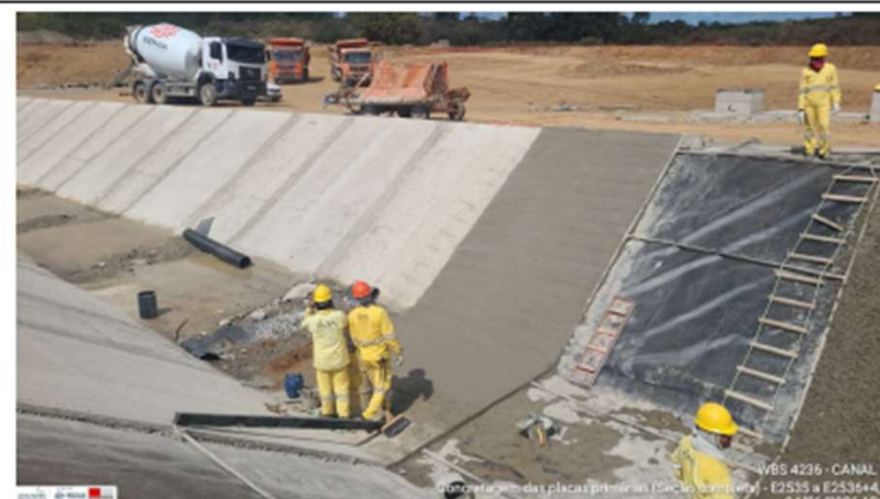
Foto 14: revestimento de canal
