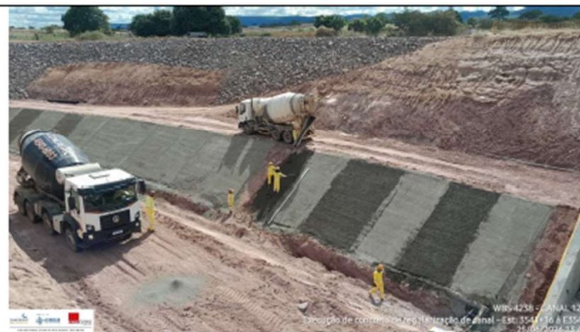
Foto 30: regularização interna de talude
