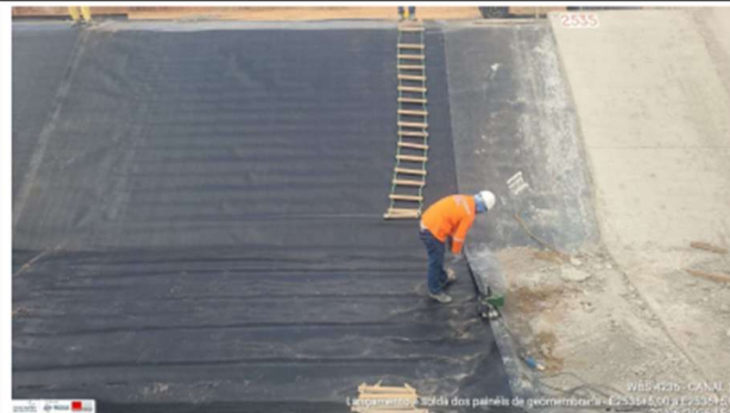
Foto 12: execução de geomembrana
