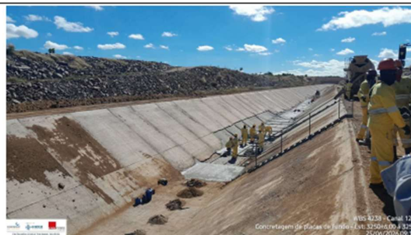
Foto 28: revestimento de canal
