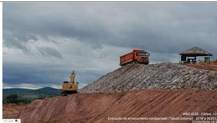
Foto 19: enrocamento de talude externo
