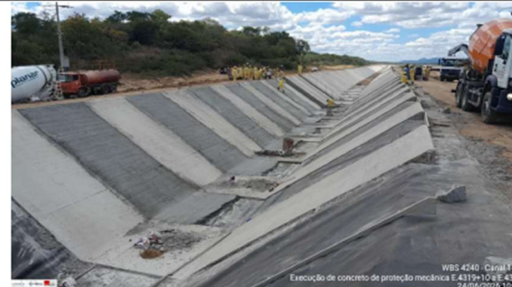
Foto 44: revestimento de canal
