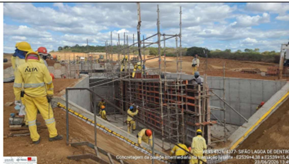
Foto 16: concretagem da parede intermediária da transição jusante
