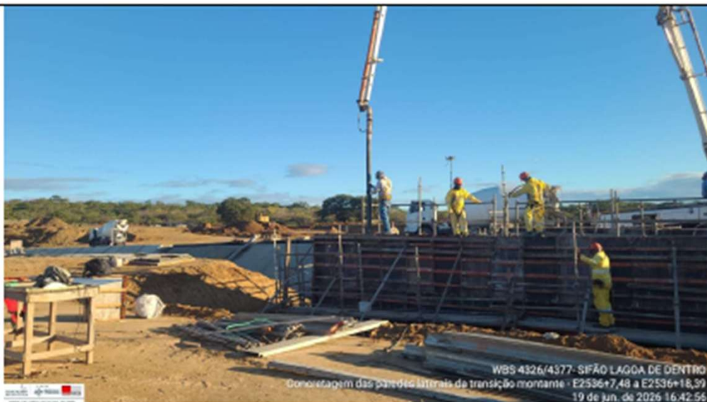
Foto 15: concretagem das paredes da transição montante
