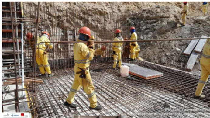
Foto 59: armação da laje de transição montante
