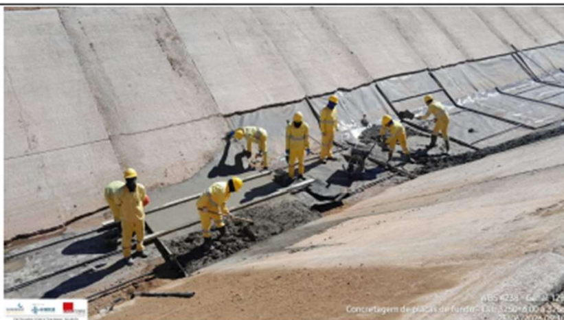
Foto 27: revestimento de canal
