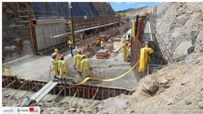
Foto 61: concretagem da laje de transição montante
