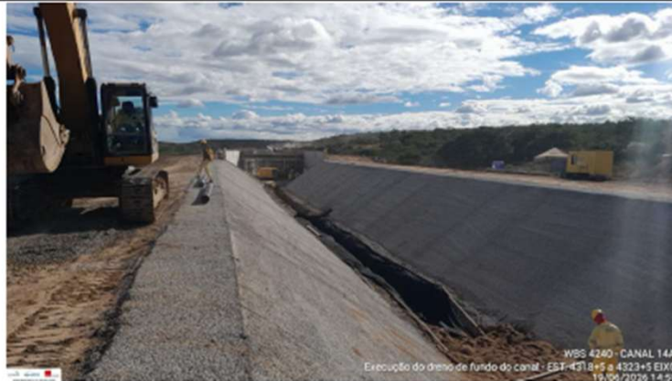
Foto 43: execução da drenagem interna
