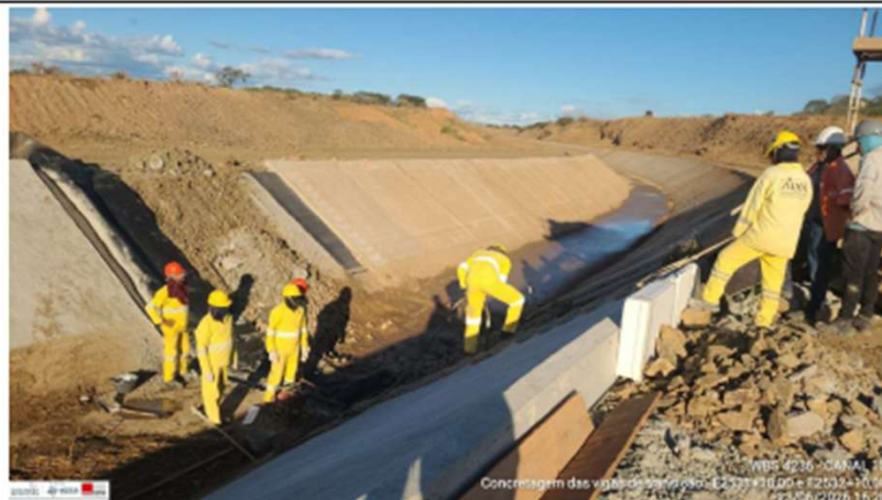
Foto 13: concretagem de viga de transição
