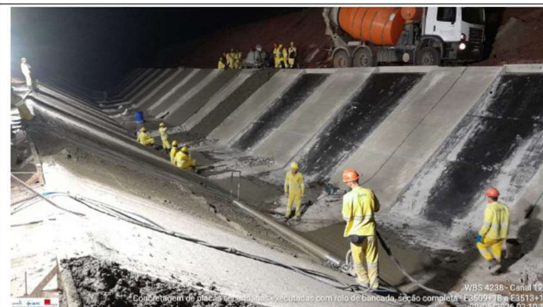
Foto 20: revestimento de canal
