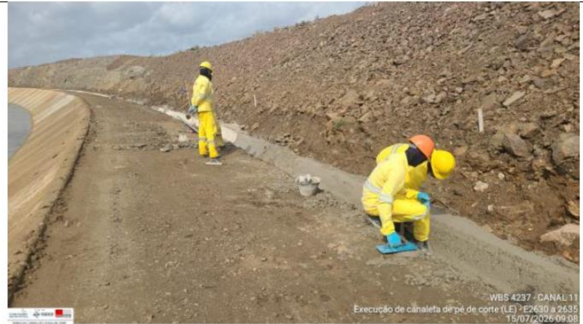
Foto 4: execução de canaleta
