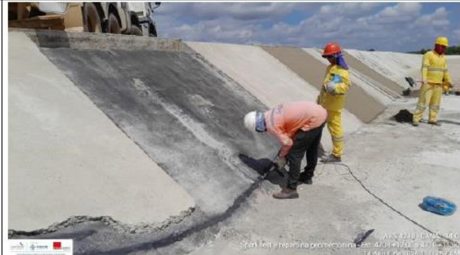
Foto 14: reparos na geomembrana
