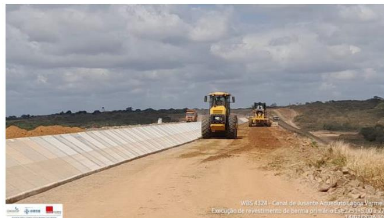
Foto 7: execução de revestimento primário de berma
