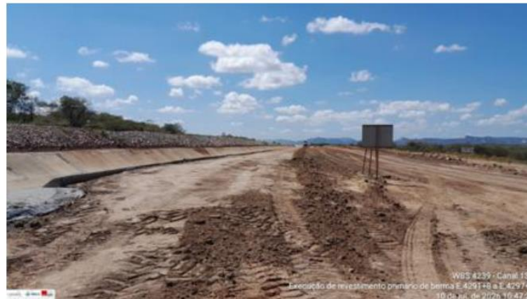
Foto 10: revestimento primário de berma
