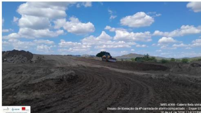
Foto 19: execução de aterro
