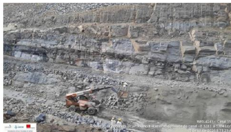
Foto 21: revestimento de canal
