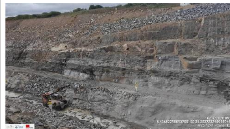
Foto 22: revestimento de canal
