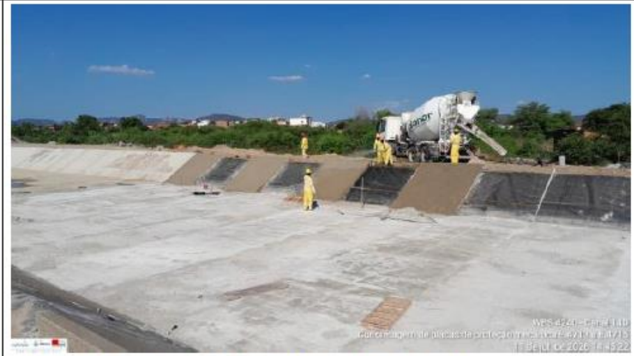
Foto 16: revestimento de canal
