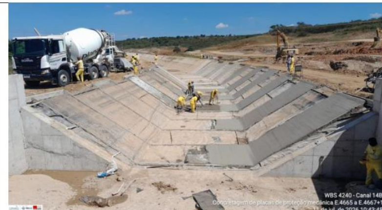
Foto 12: concretagem das placas de proteção
