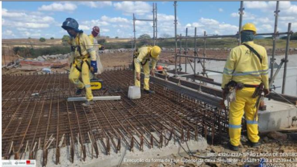
Foto 1: execução de forma da laje superior da caixa jusante
