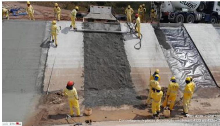
Foto 9: concretagem das placas de proteção
