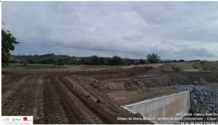
Foto 20: execução de aterro
