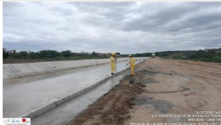
Foto 15: execução da calçada de proteção
