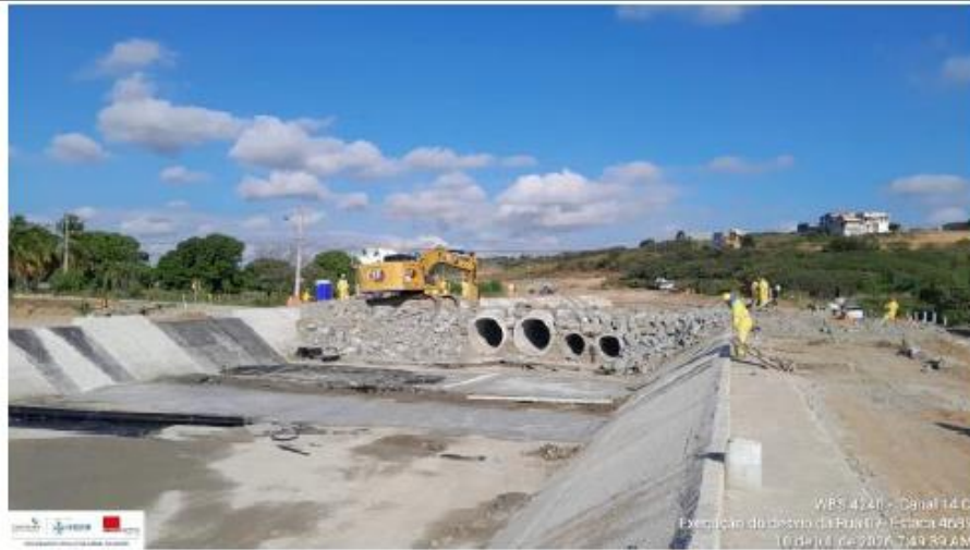
Foto 13: execução do desvio da Rua 7
