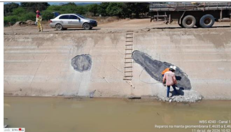
Foto 11: reparos na geomembrana
