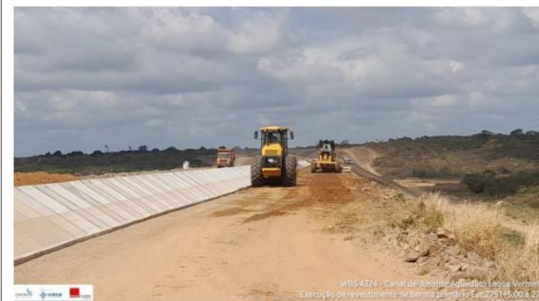
Foto 8: execução de revestimento primário de berma
