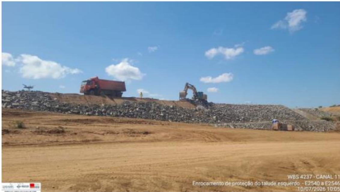
Foto 3: encoramento de talude externo
