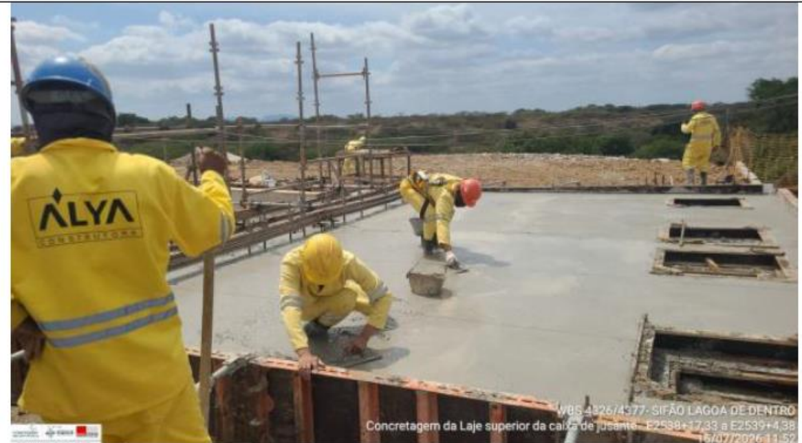
Foto 2: concretagem da laje superior da caixa jusante
