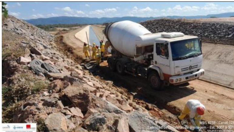
Foto 5: execução de canaleta
