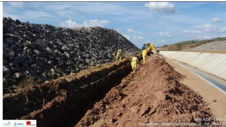
Foto 6: execução de canaleta
