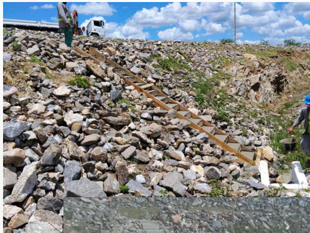
Construção de escadas de acesso ao MV-03 do Res. Góis
