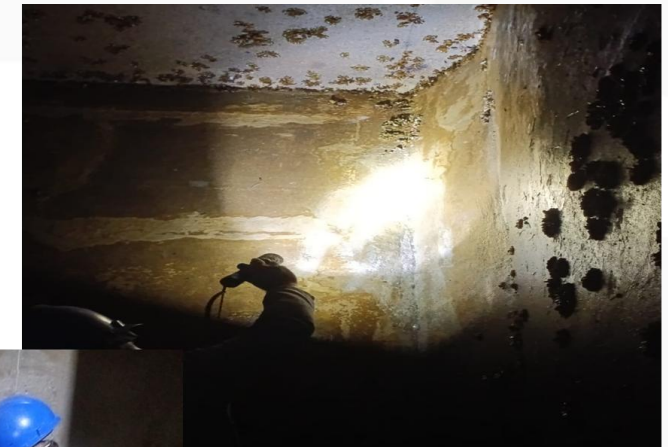
Limpeza e correção de fissuras no poço de sucção na EBVII-1
