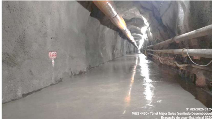
Foto 51: execução do piso
