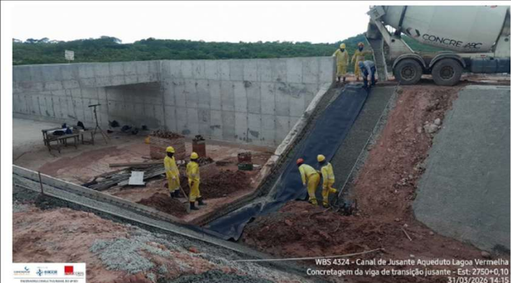
Foto 16: concretagem da viga de transição jusante
