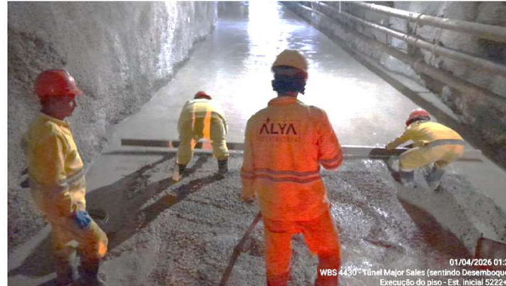
Foto 52: execução do piso
