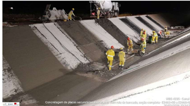
Foto 6: revestimento de canal
