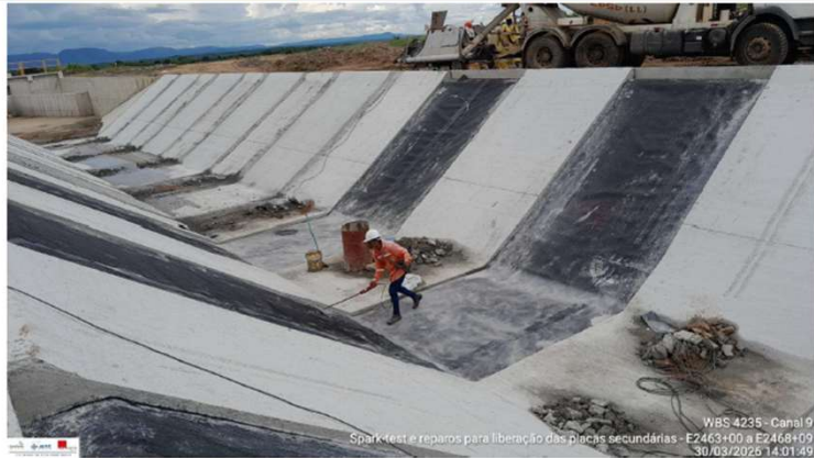
Foto 5: execução de geomembrana
