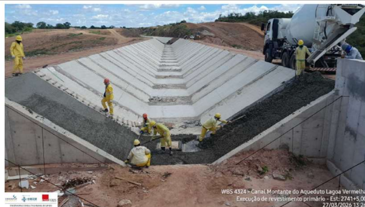
Foto 15: revestimento de canal
