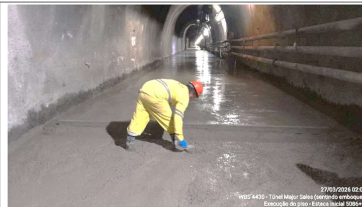
Foto 53: execução do piso
