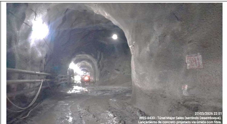
Foto 54: execução de concreto projetado
