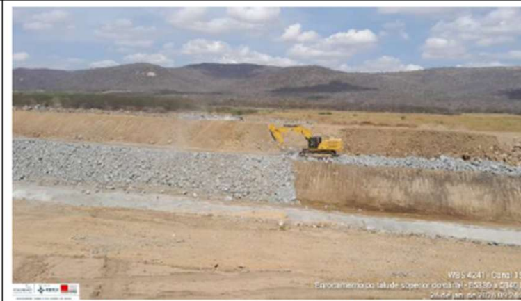
Foto 48: enrocamento do talude externo
