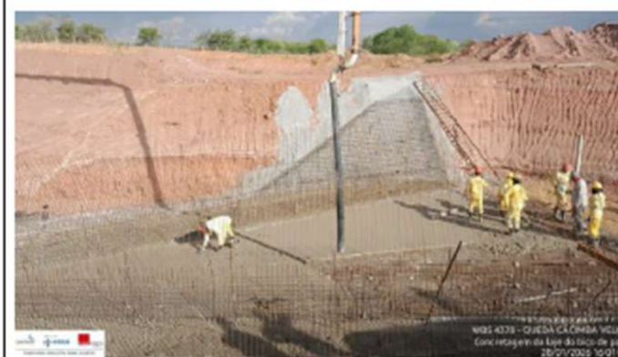
Foto 22: concretagem da laje do bico de pato
