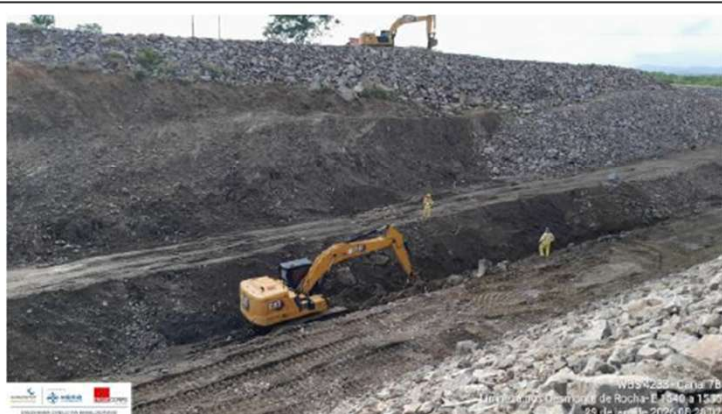
Foto 3: limpeza após desmonte de rocha
