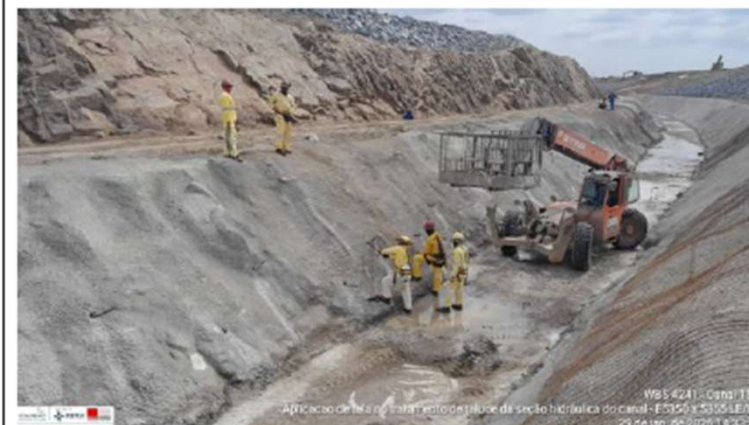
Foto 46: revestimento de canal
