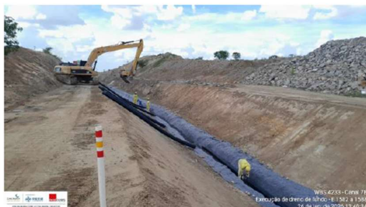
Foto 1: execução do dreno de fundo
