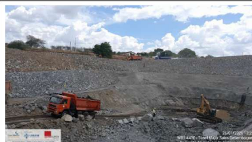
Foto 43: remoção mat. 3ª categoria desemboque
