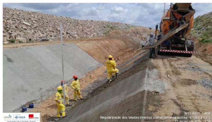
Foto 2: regularização interna de talude
