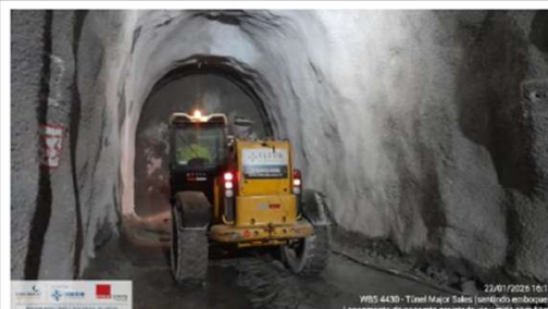
Foto 40: execução de concreto projetado
