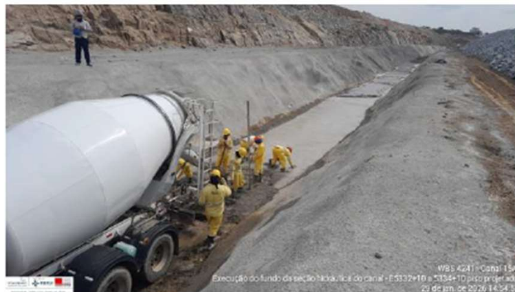
Foto 45: revestimento de canal
