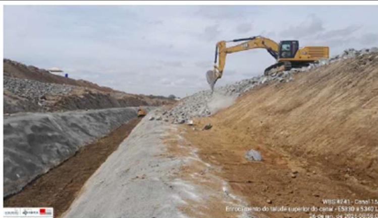
Foto 47: enrocamento do talude externo
