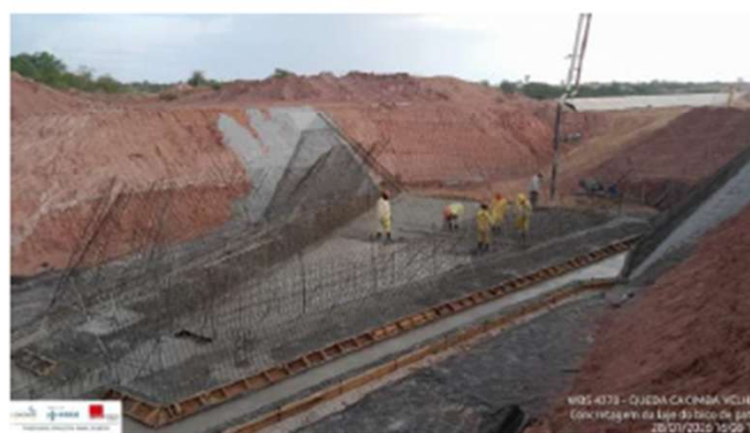
Foto 21: concretagem da laje
