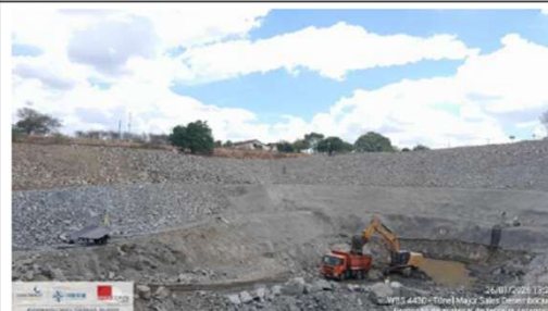
Foto 44: remoção mat. 3ª categoria desemboque
