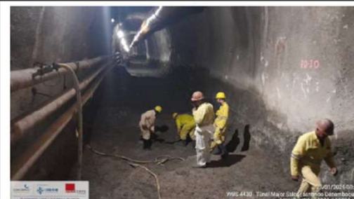
Foto 42: execução do arco invertido
