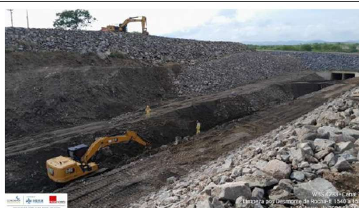
Foto 4: enrocamento de proteção externa do talude
