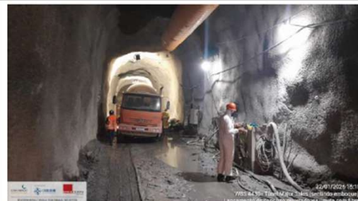
Foto 39: execução de concreto projetado
