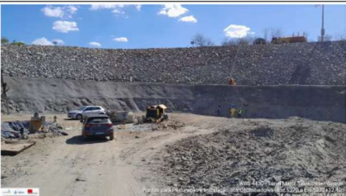
Foto 45: perfuração para instalação dos chumbadores
