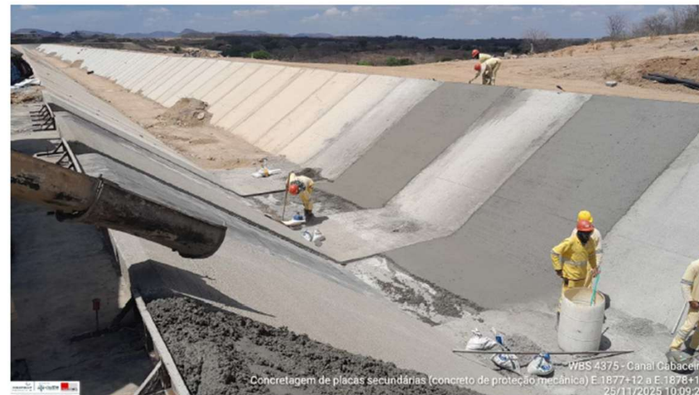
Foto 4: concretagem de placas
