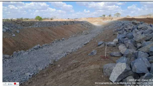
Foto 49: revestimento de canal
