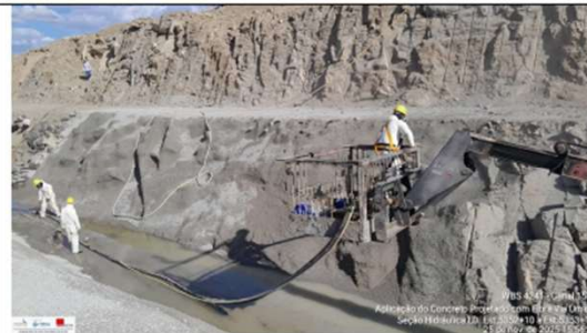
Foto 50: lançamento de concreto projetado
