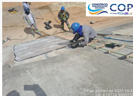
Soldagem da Geomembrana PVC
