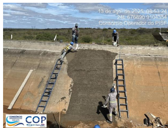
Concretagem das placas
