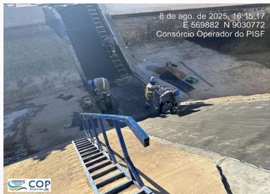
Soldagem da Geomembrana PEAD
