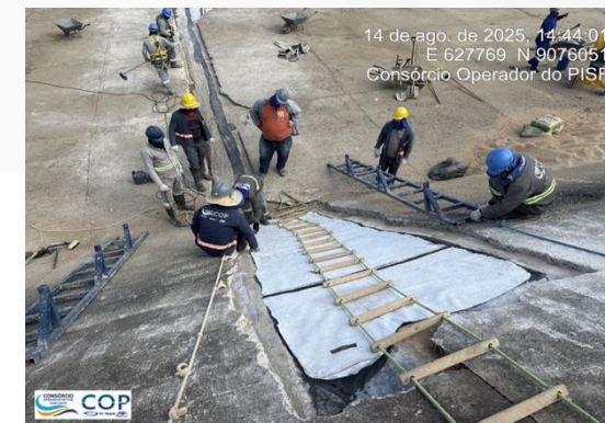
Soldagem da Geomembrana PVC
