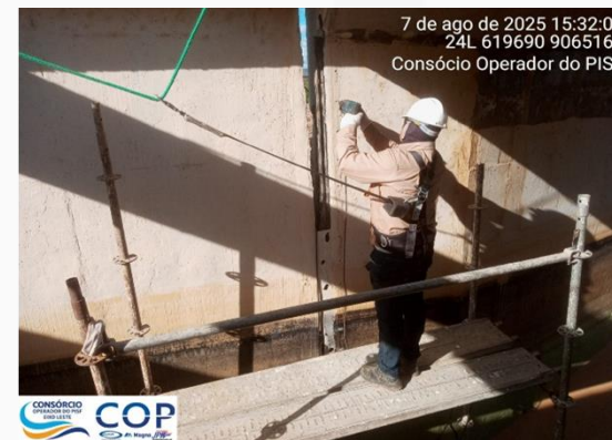
Instalação de manta e fixação de barras chatas
