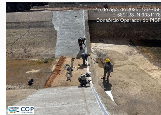
Aplicação de mastique na junta de dilatação
