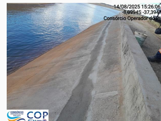
Tratamento de trincas nas placas adjacentes
