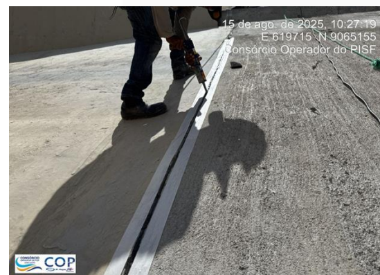
Aplicação de mastique na junta de dilatação
