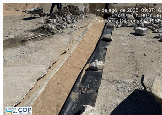
Complemento do material drenante sob a manta
