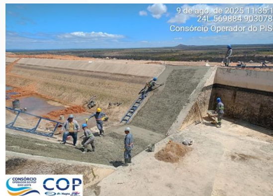
Concretagem das placas
