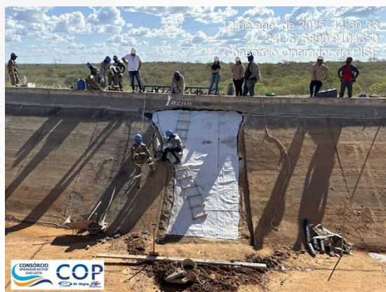
Soldagem da geomembrana PVC
