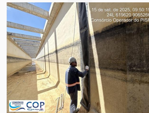
Instalação de manta e fixação de barras chatas (Jusante)
