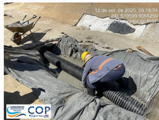
Desobstrução e substituição do dreno de fundo Jusante
