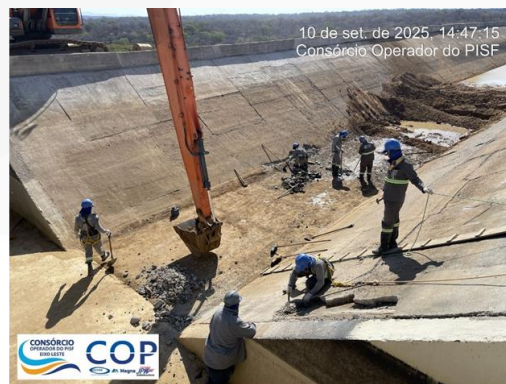
Demolição do concreto danificado para investigações Jusante
