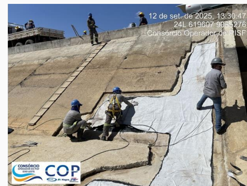
Substituição de manta PVC danificada por nova
