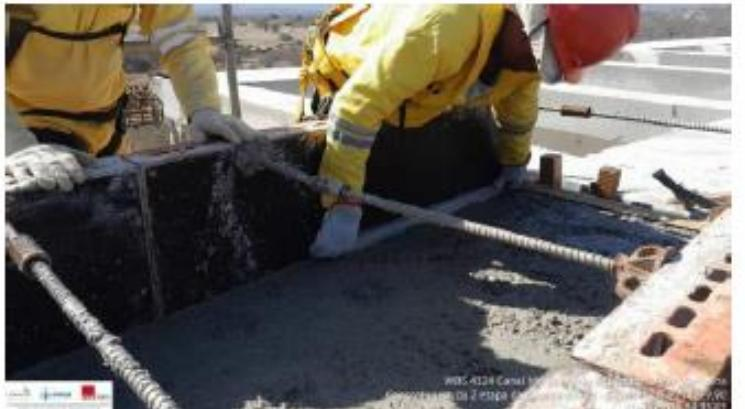
Foto 15: concretagem da parede da transição jusante
