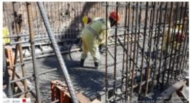
Foto 13: concretagem da laje 01
