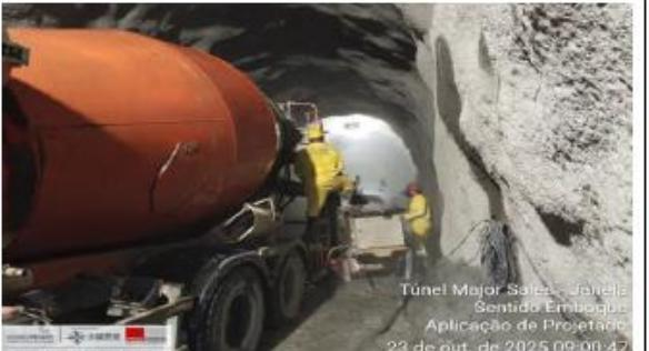
Foto 33: aplicação de concreto projetado
