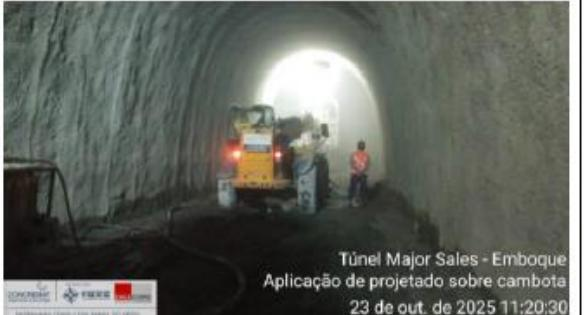
Foto 31: aplicação de projetado sobre cambota
