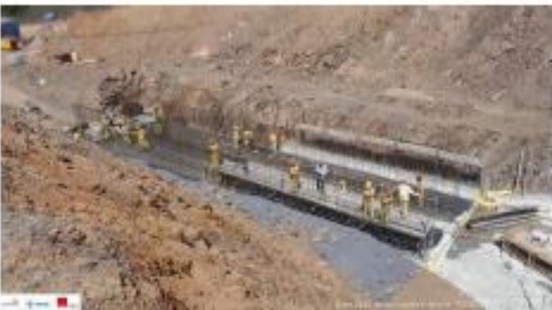
Foto 14: armação e montagem de forma das paredes
