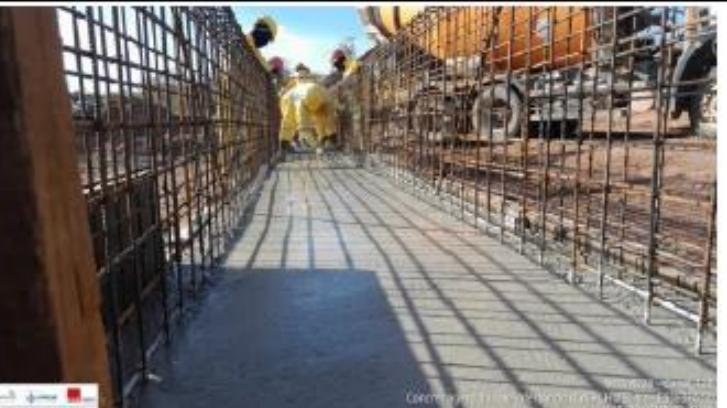
Foto 18: concretagem da laje inferior do overchute 01
