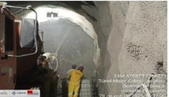
Foto 34: aplicação de concreto projetado
