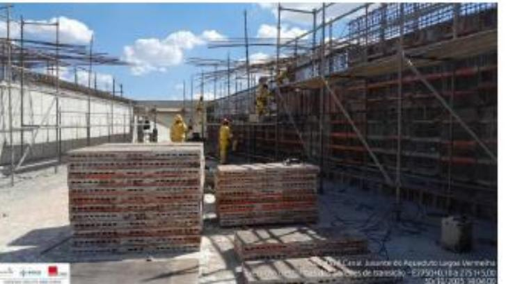
Foto 16: montagem de forma da parede da transição jusante
