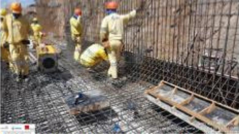
Foto 12: montagem de forma da laje 01
