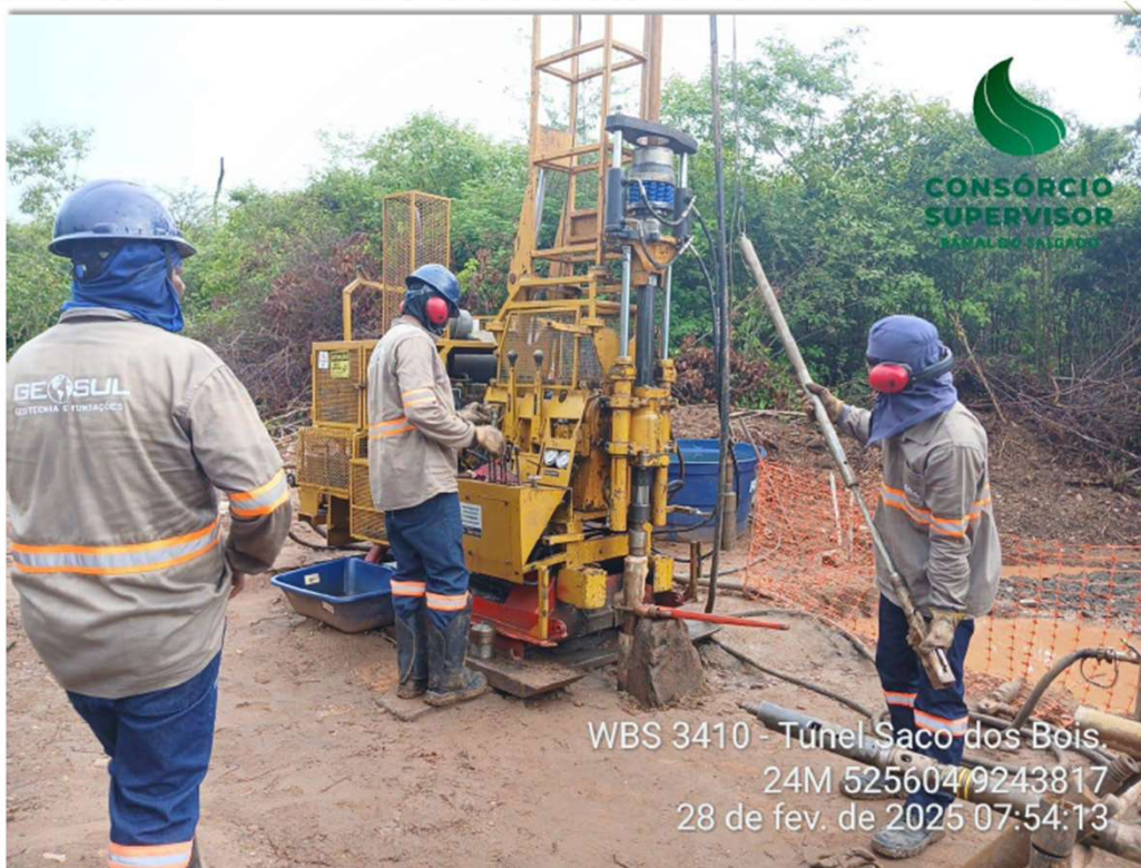
Ensaio em andamento
