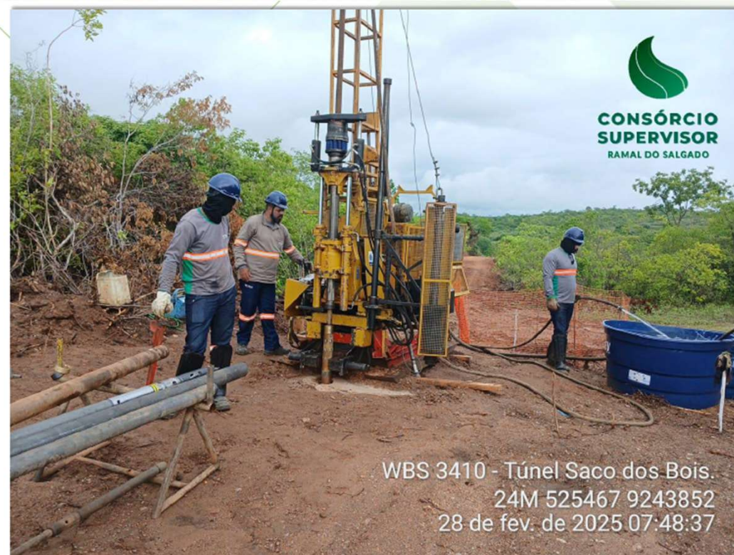
Ensaio em andamento
