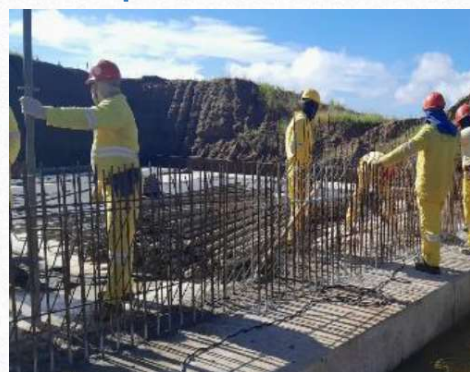
Aqueduto Pedra Preta
