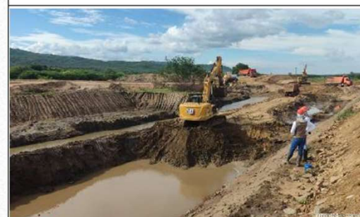
Foto 41: escavação do corte obrigatório
