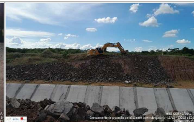
Foto 18: enrocamento de proteção
