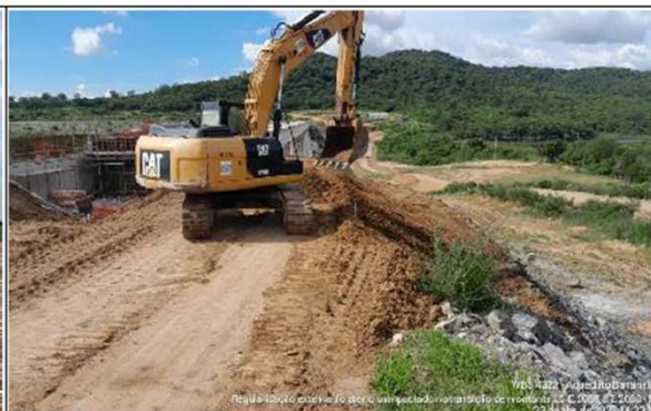
Foto 6: regularização do talude externo – transição de montante
