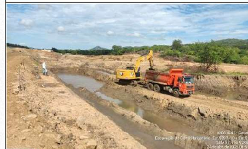
Foto 39: escavação do corte obrigatório
