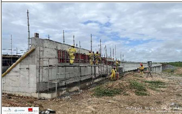
Foto 5: desforma – transição de jusante
