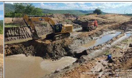
Foto 40: escavação do corte obrigatório
