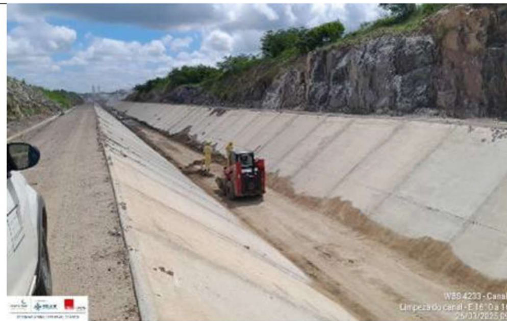
Foto 2: Limpeza de fundo de canal
