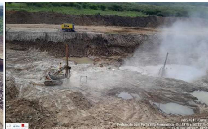
Foto 60: perfuração para desmonte de rocha
