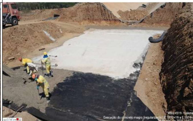
Foto 10: execução do concreto de regularização
