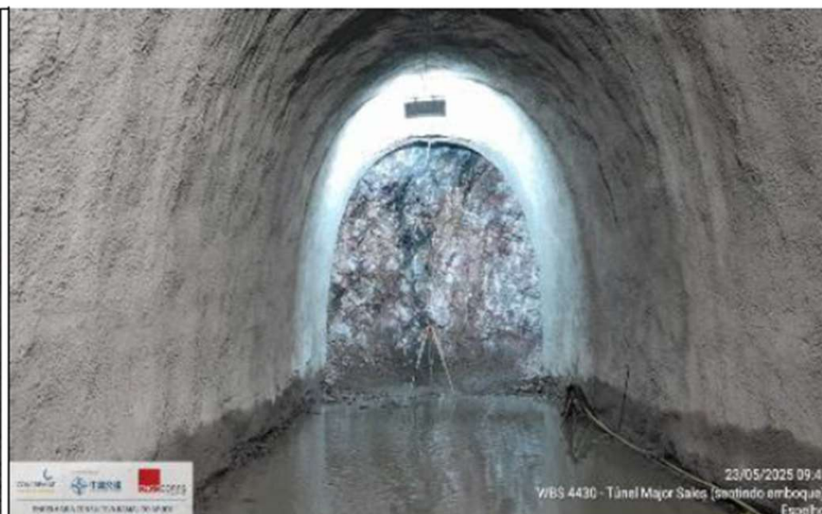
Foto 58: Sentido Emboque: marcação dos pontos para perfuração
