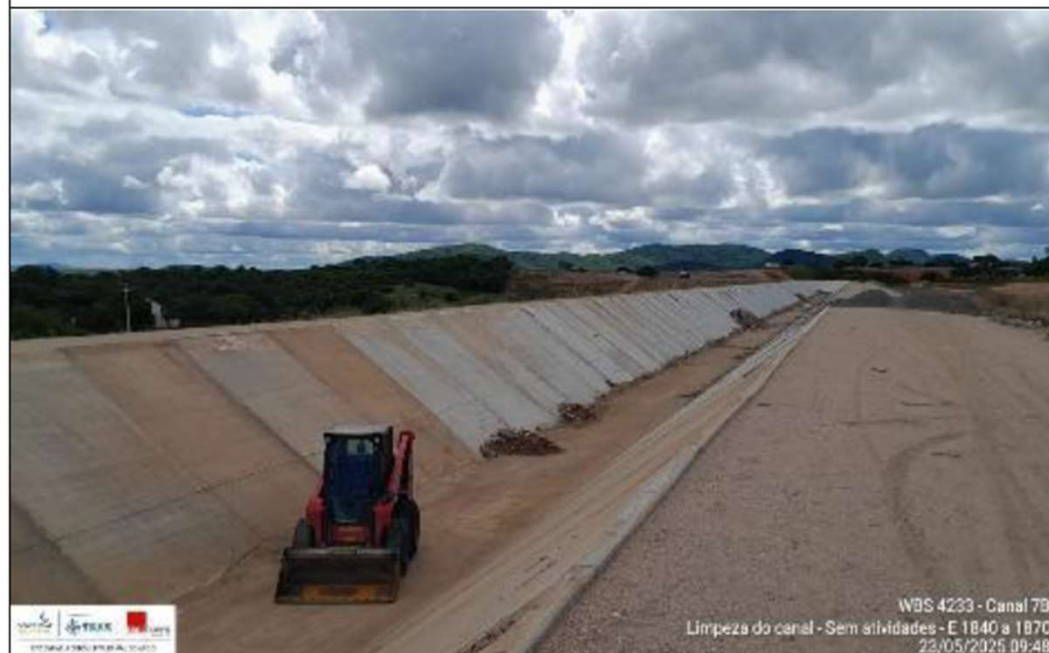
Foto 1: limpeza de fundo de canal
