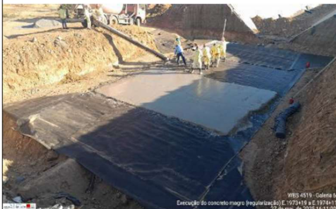
Foto 9: execução do concreto de regularização
