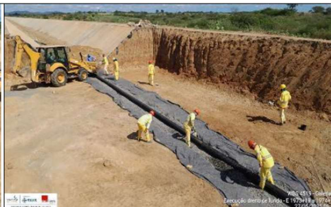
Foto 8: execução do dreno de fundo
