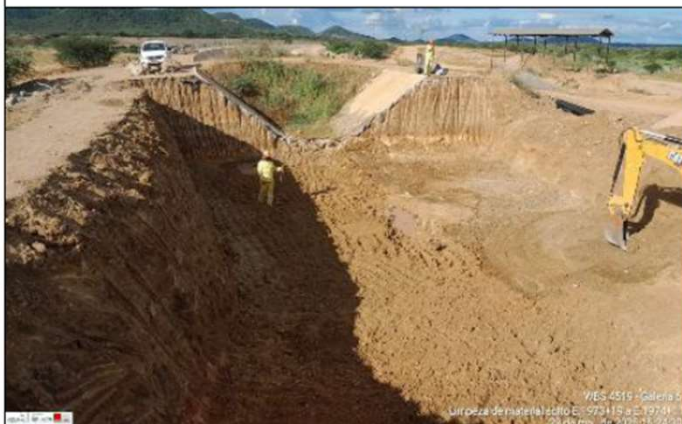
Foto 7: escavação da galeria
