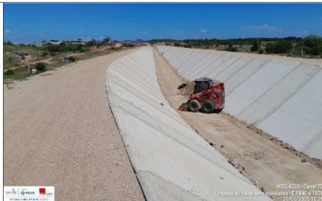
Foto 2: limpeza de fundo de canal
