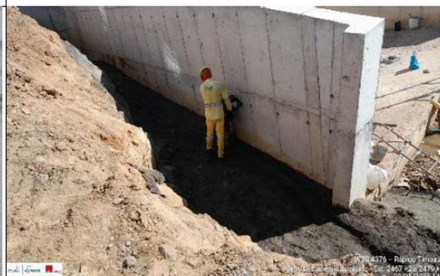
Foto 18: execução do reaterro lateral
