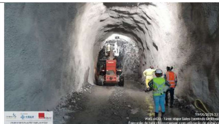
Foto 51: execução de bate choco
