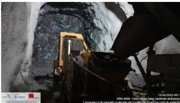
Foto 50: lançamento de concreto projetado
