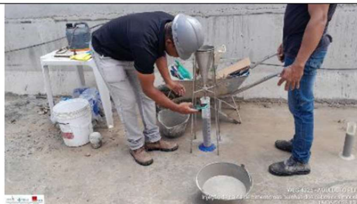
Foto 45: injeção de calda de cimento nas bainhas dos cabos dos módulos
