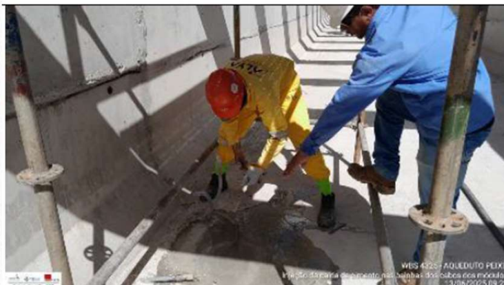
Foto 44: injeção de calda de cimento nas bainhas dos cabos dos módulos
