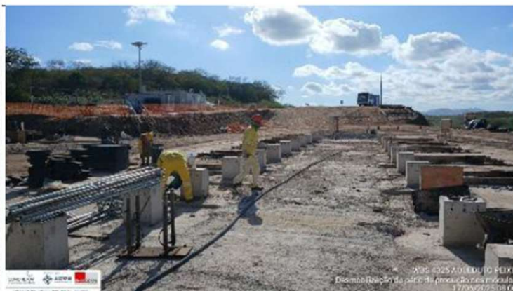
Foto 46: desmobilização do pátio de montagem dos módulos
