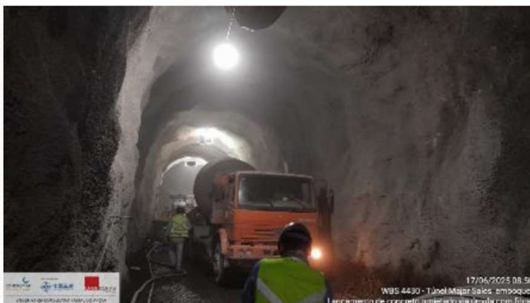
Foto 48: lançamento de concreto projetado
