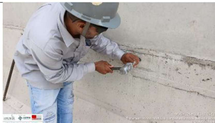
Foto 47: vedação dos buracos das agulhas
