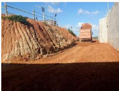
Execução do aterro compactado
