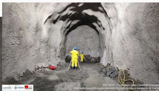
Marcação topográfica e execução de bate choco;
