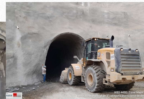
Perfuração com Jumbo e remoção de material de 3ª categoria;
