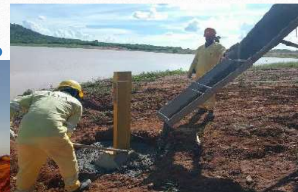
Instalação da réguas linimétricas
