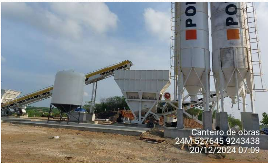
FOTO 01 - CANTEIRO DE OBRAS (CENTRAL DE CONCRETO)
