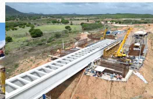
Empurramento do Módulo 6 - Superestrutura
