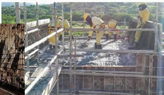
Concretagem Laje superior
