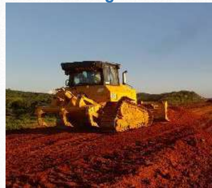
Execução de aterro compactado
