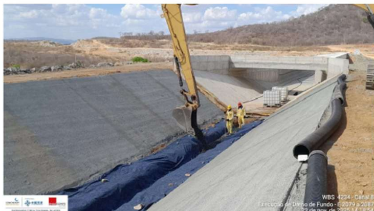
Foto 7: execução de drenagem interna
