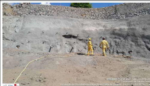
Foto 46: injeção da calda do cimento
