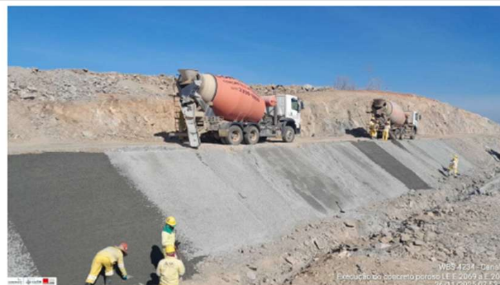
Foto 10: regularização interna de talude
