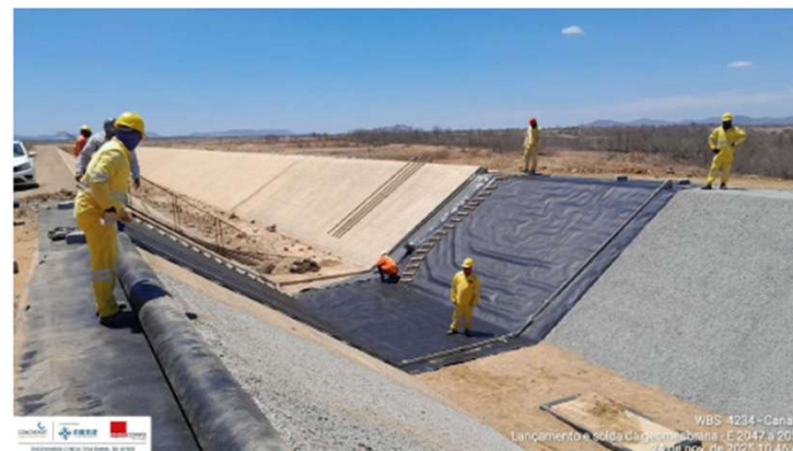
Foto 8: execução de geomembrana
