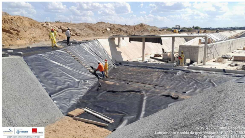
Foto 3: execução de geomembrana
