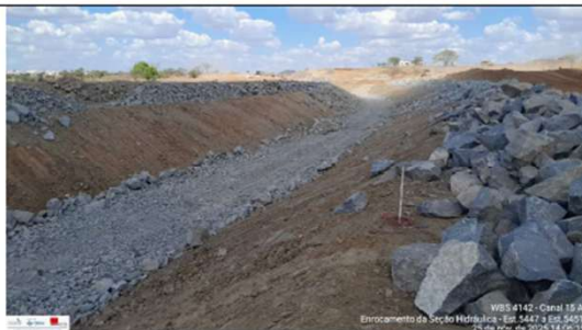
Foto 49: revestimento de canal
