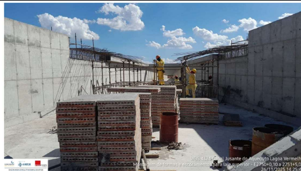
Foto 20: montagem de forma da laje superior
