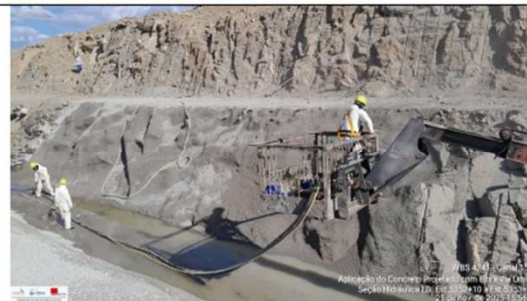
Foto 50: lançamento de concreto projetado
