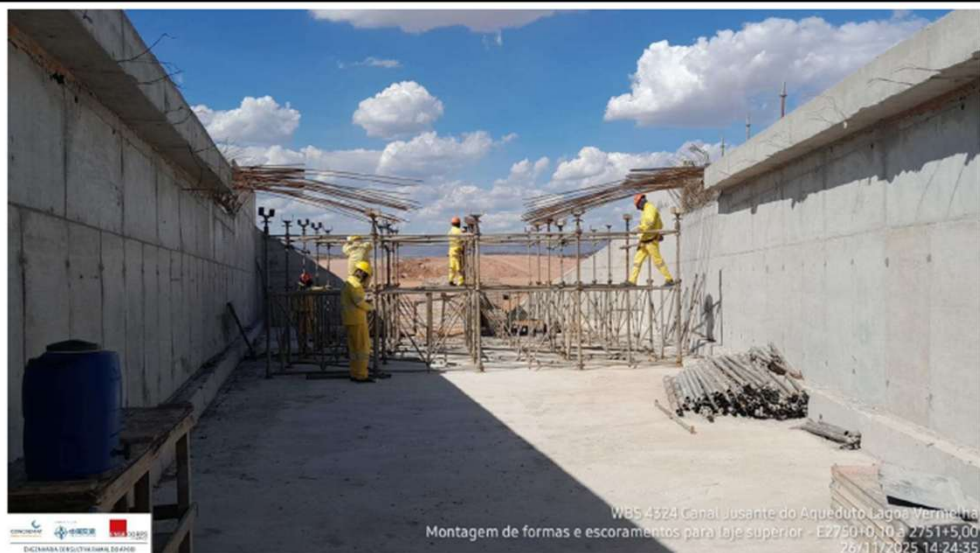
Foto 19: montagem de forma da laje superior
