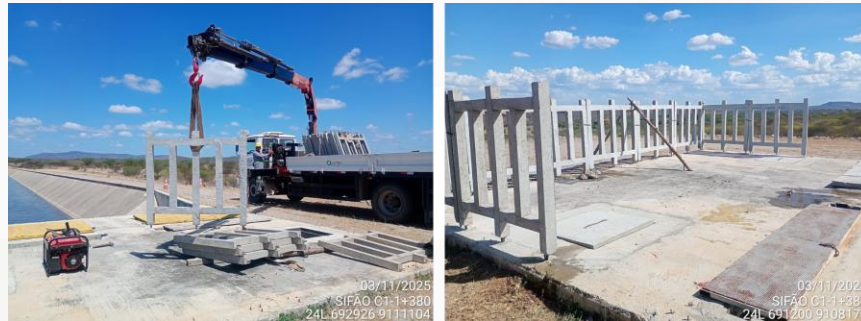
Instalação de guarda-corpos no Emboque do Sifão Passagem
