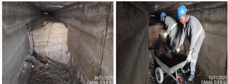
Desobstrução e Limpeza interna do bueiro B-43 (Canal C9). Estaca 40+690
