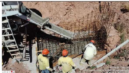
Foto 11: concretagem de laje de medidor de vazão
