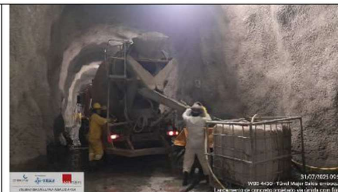
Foto 38: lançamento de concreto projetado
