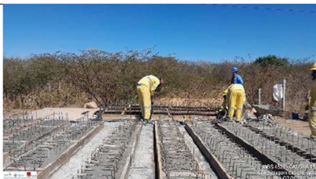
Foto 35: concretagem das pré-lajes
