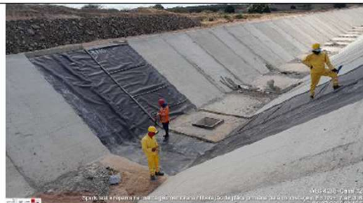
Foto 13: execução da geomembrana
