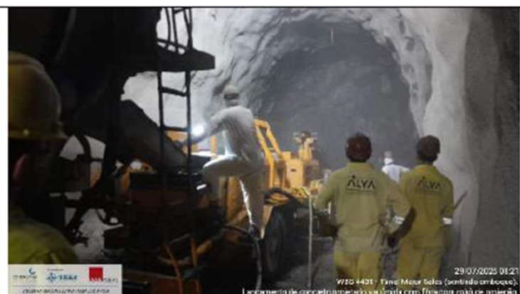
Foto 40: lançamento de concreto projetado
