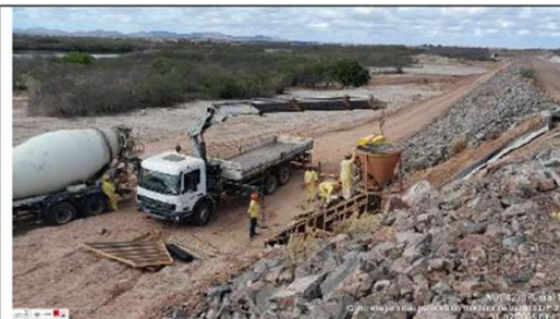
Foto 12: concretagem das paredes do medidor de vazão
