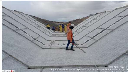
Foto 15: execução da geomembrana
