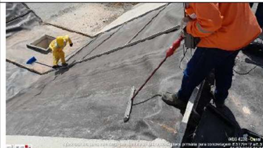
Foto 14: execução da geomembrana
