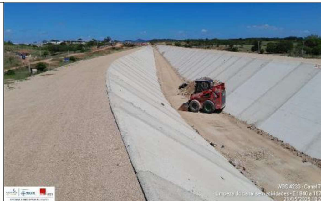
Foto 2: limpeza de fundo de canal
