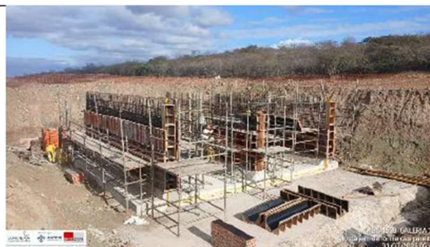
Foto 36: montagem de forma das paredes
