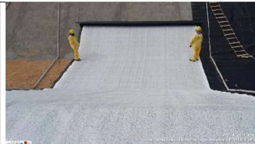
Foto 16: lançamento de geomembrana
