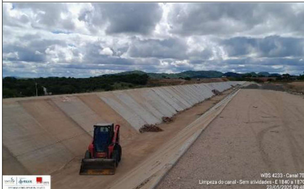
Foto 1: limpeza de fundo de canal
