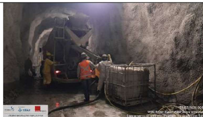
Foto 37: lançamento de concreto projetado
