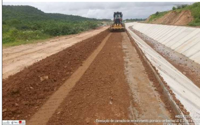
Foto 1: execução de revestimento primário
