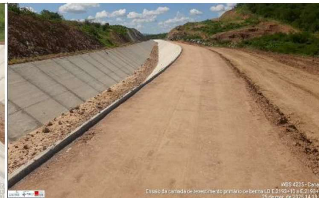
Foto 2: execução de revestimento primário
