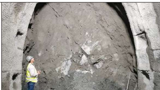
Foto 2: Sentido Desemboque: execução de concreto projetado
