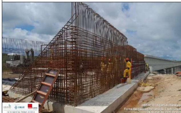
Foto 1: armação de ferragem das paredes de transição jusante
