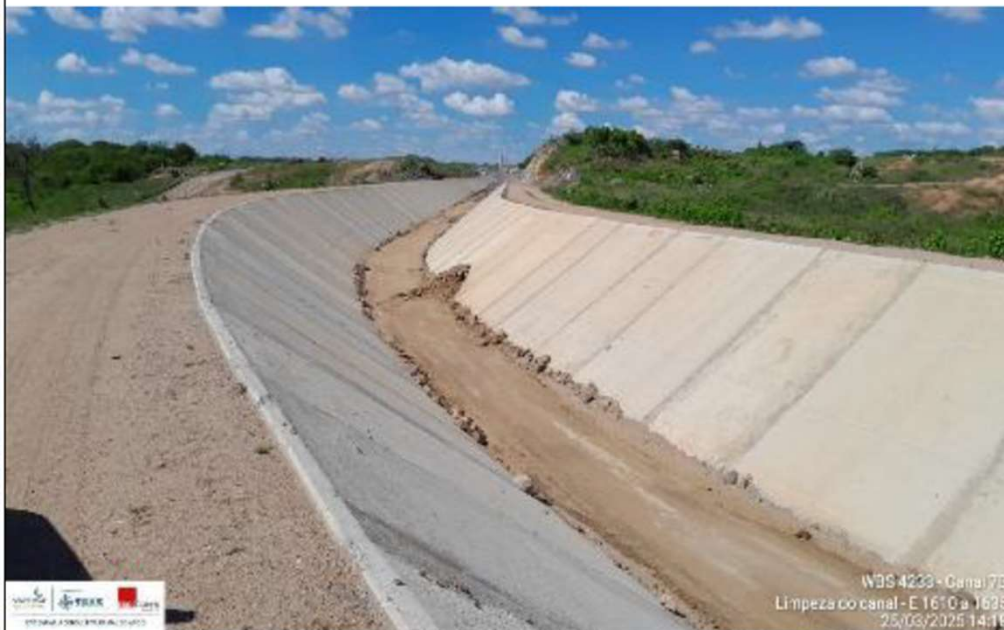
Foto 1: limpeza de fundo de canal
