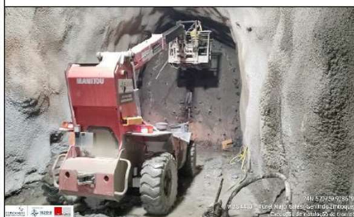
Foto 3: Sentido Emboque: instalação de tirantes
