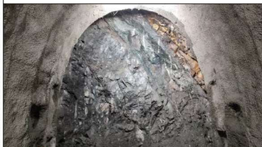
Foto 1: Sentido Desemboque: execução de bate-choco
