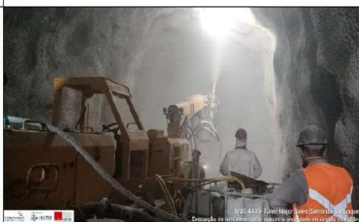
Foto 4: Sentido Emboque: execução de concreto projetado
