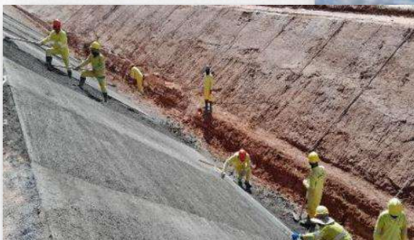
Regularização do talude interno
