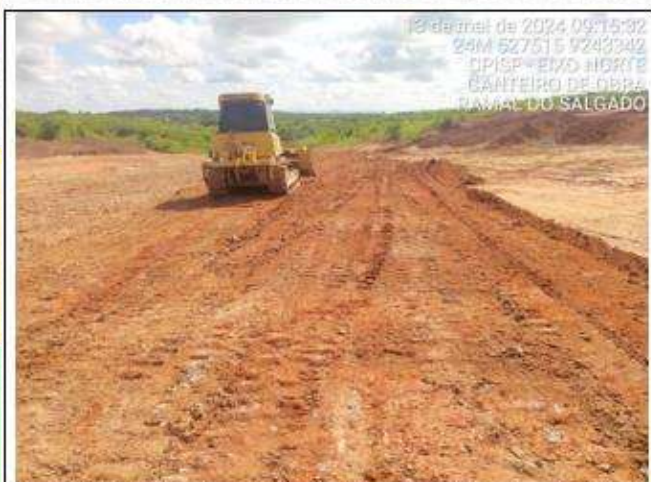
Foto 23: Visão atual do canteiro de obras do Consórcio ENGIBRAS/SMF. Espalhamento das camadas de solo lançadas para regularização do platô.
