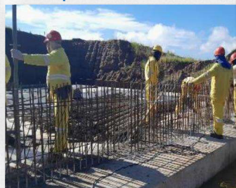
Aqueduto Pedra Preta
