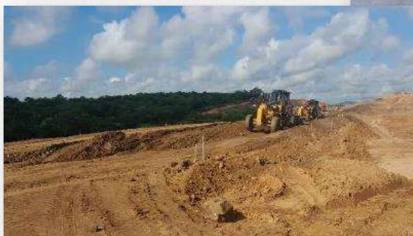
Execução do aterro compactado
