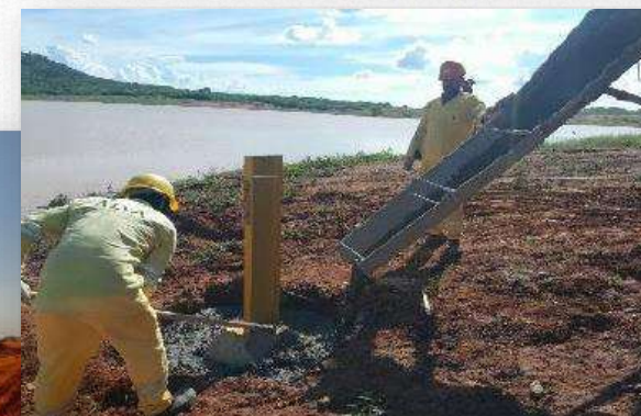
Instalação da réguas linimétricas
