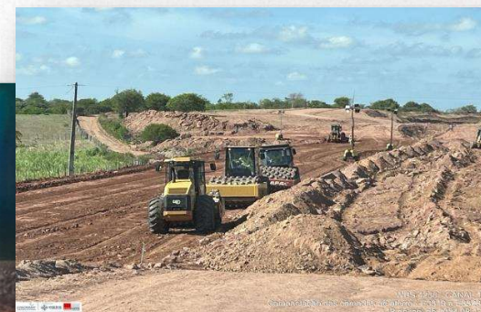
Execução de aterro compactado (diurno e noturno).
