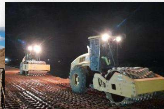
Execução de aterro compactado.
