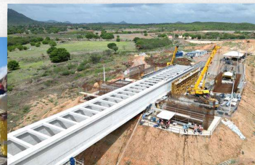
Empurramento do Módulo 6 - Superestrutura
