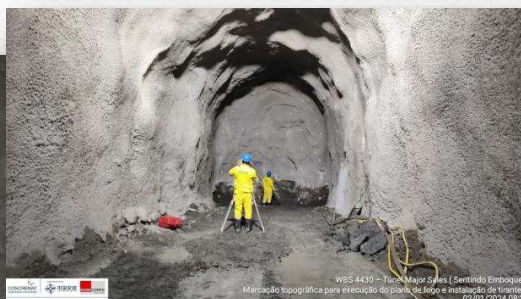
Marcação topográfica e execução de bate choco;
