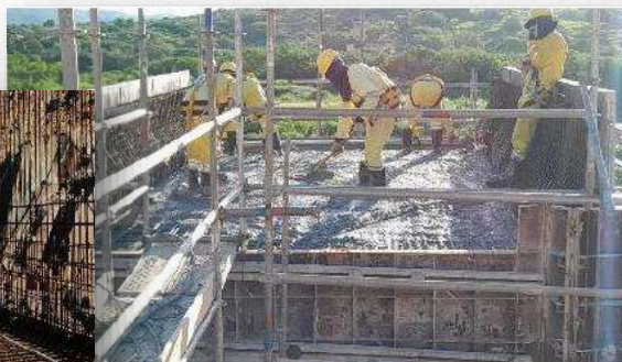
Concretagem Laje superior
