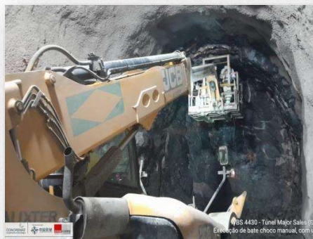
Túnel Major Sales Janela sentido Desemboque
