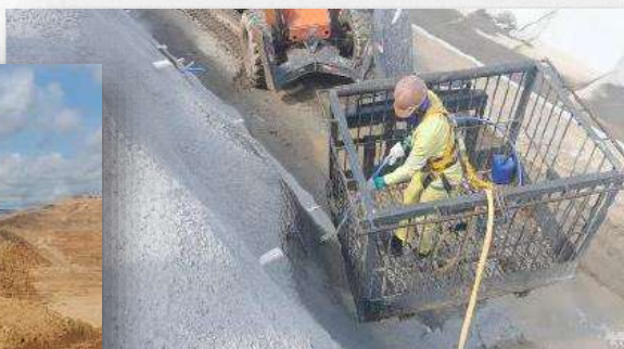
Execução do concreto projetado
