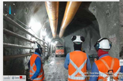
Túnel Major Sales Janela sentido Desemboque
