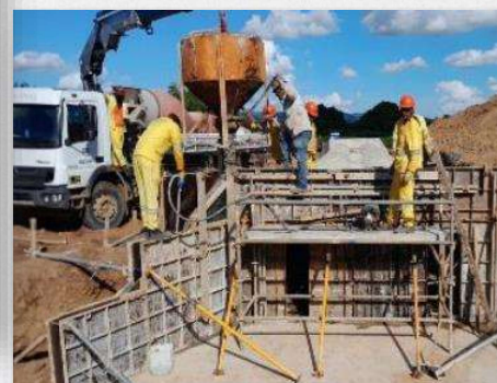
Concretagem da ala montante no Bueiro 13.
