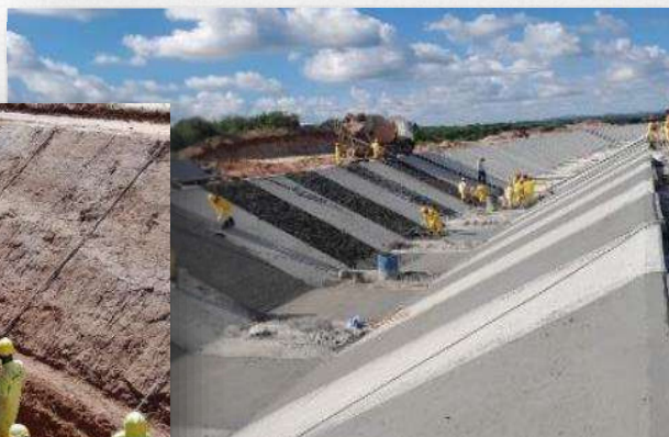
Execução das placas de proteção.
