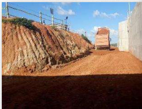
Execução do aterro compactado
