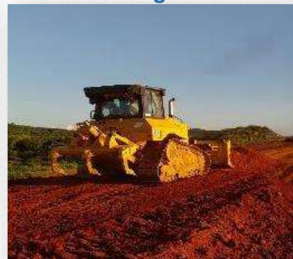
Execução de aterro compactado
