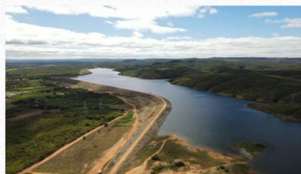
Reservatório Boi I ( WBS 1116)
