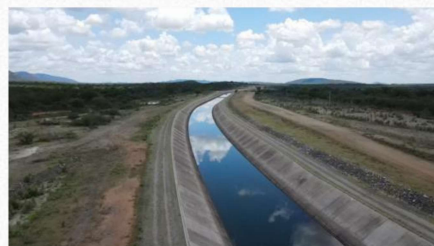
Segmento de Canal CN05 ( WBS 1209)
