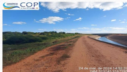
Segmento de Canal ( WBS 1229)
