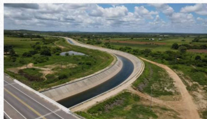
Segmento de Canal CN17 ( WBS 1224)
