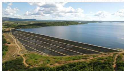
Reservatório Boa Vista ( WBS 1119)
