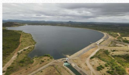
Reservatório Serra do Livramento ( WBS 1107)
