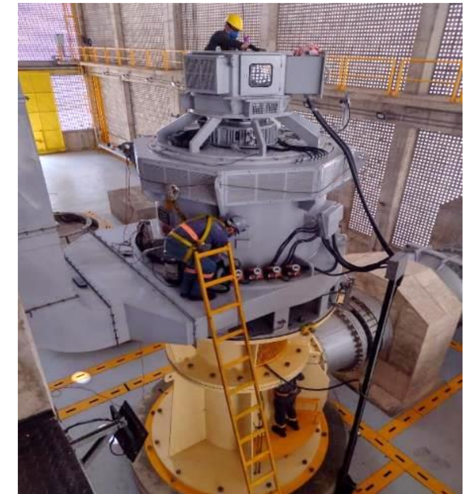
INSPEÇÃO TERMOSTATOS DAS MBS
