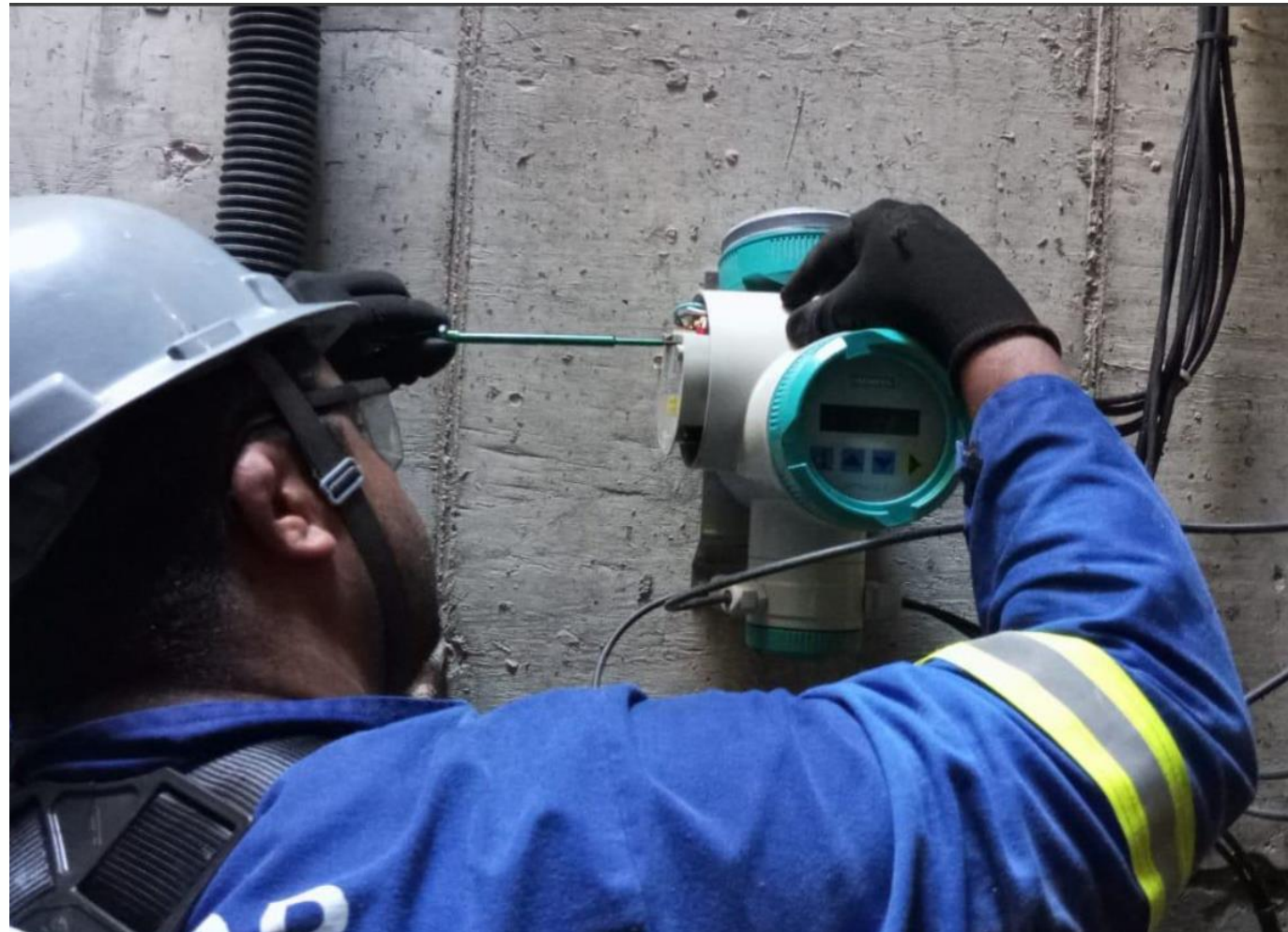
INSPEÇÃO MEDIDOR DE VAZÃO DAS MBs
