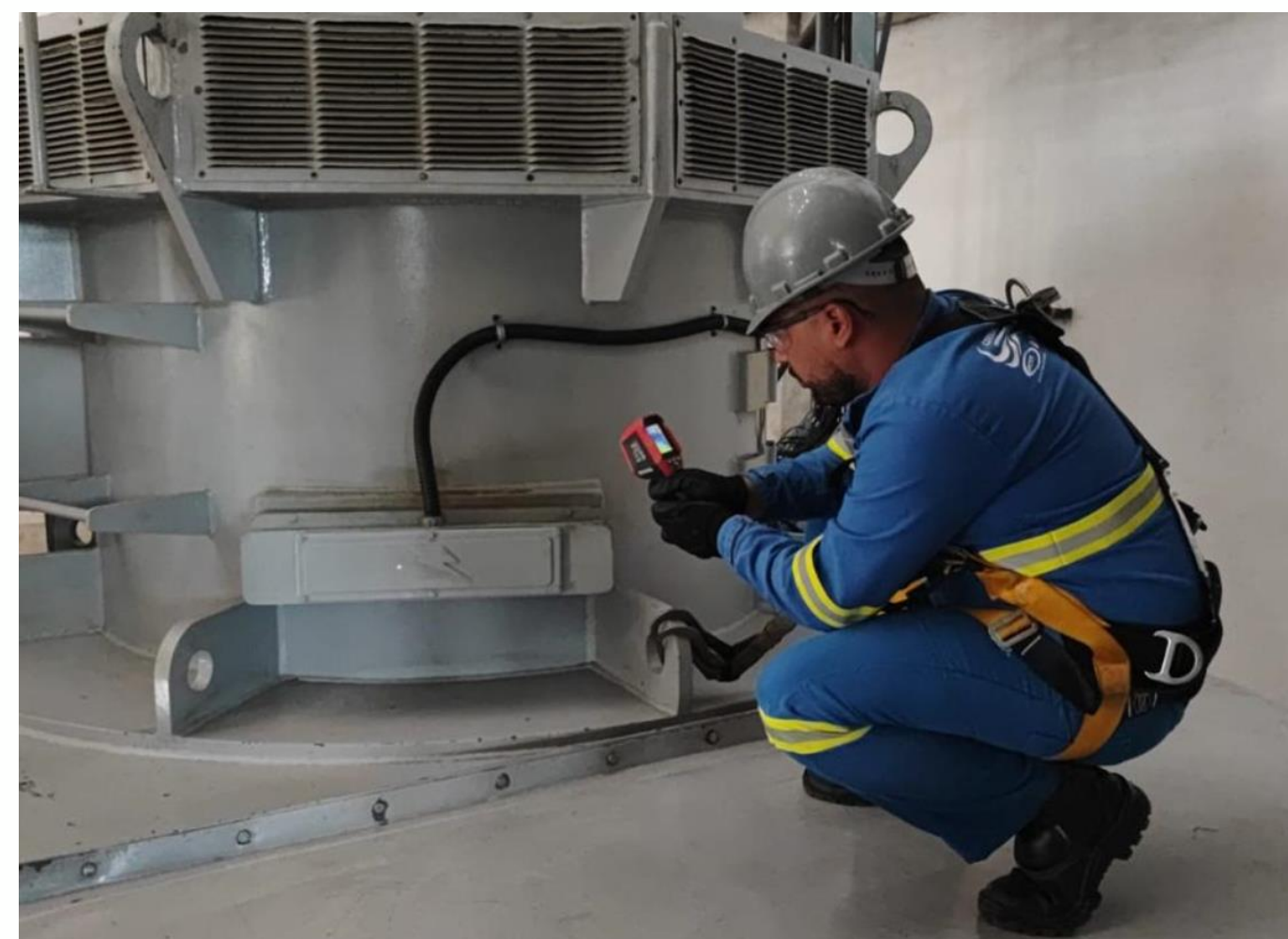
INSPEÇÃO TERMOGRAFICA NA RESISTENCIA AQUECIMENTO DO MOTOR
