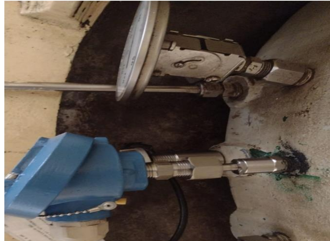
SUBSTITUIÇÃO SENSOR TEMPERATURA DA BOMBA
