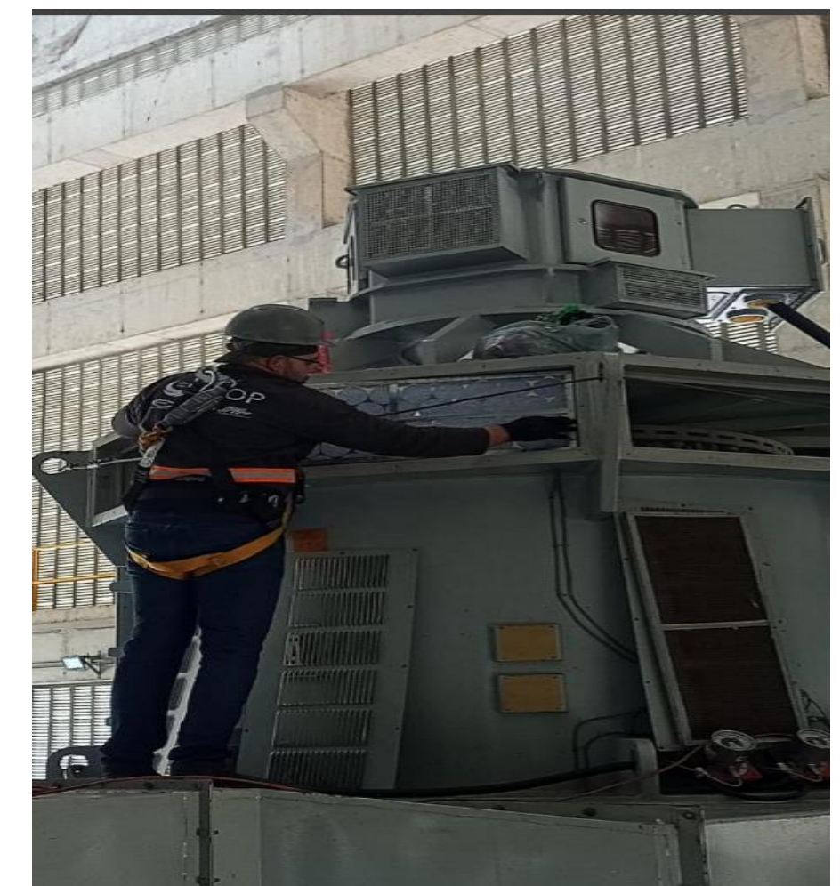
SUBSTITUIÇÃO FILTROS DO MOTOR
