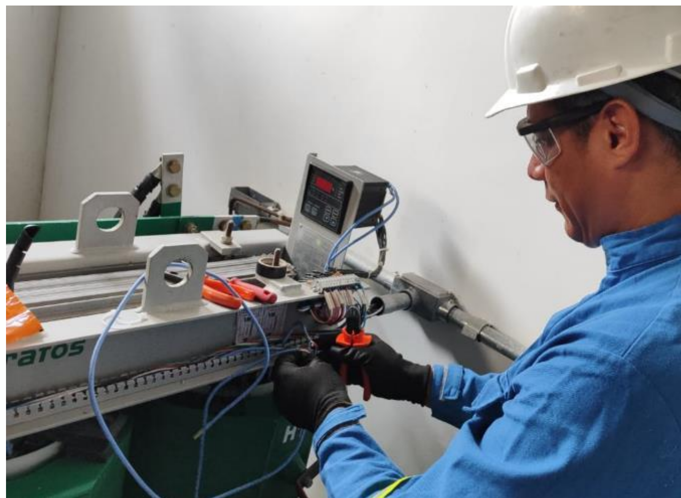
SUBSTITUIÇÃO SENSOR PT100 DO TRAF0
