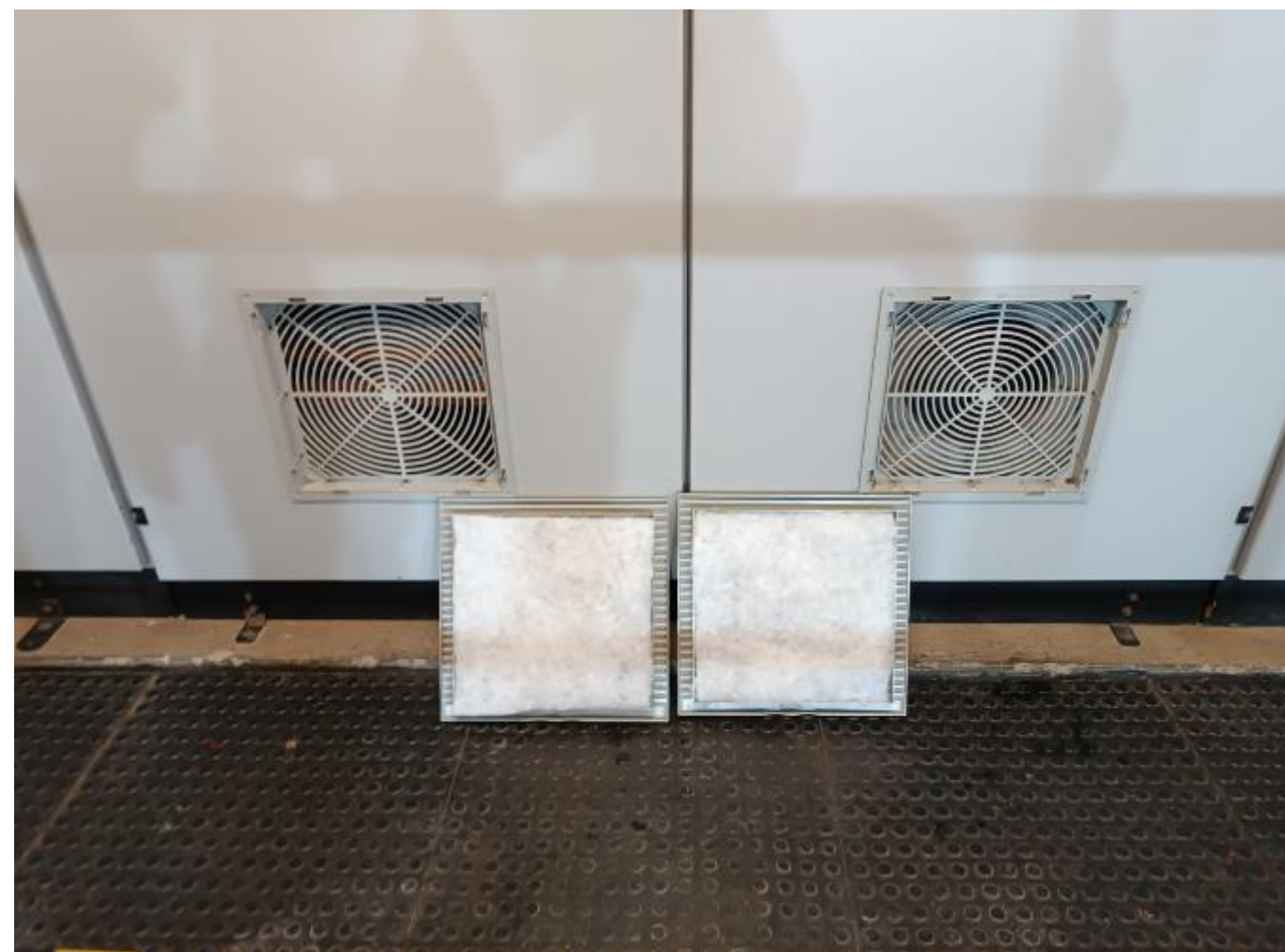
SUBSTITUIÇÃO DE FILTROS DOS PAINES ELETRICOS
