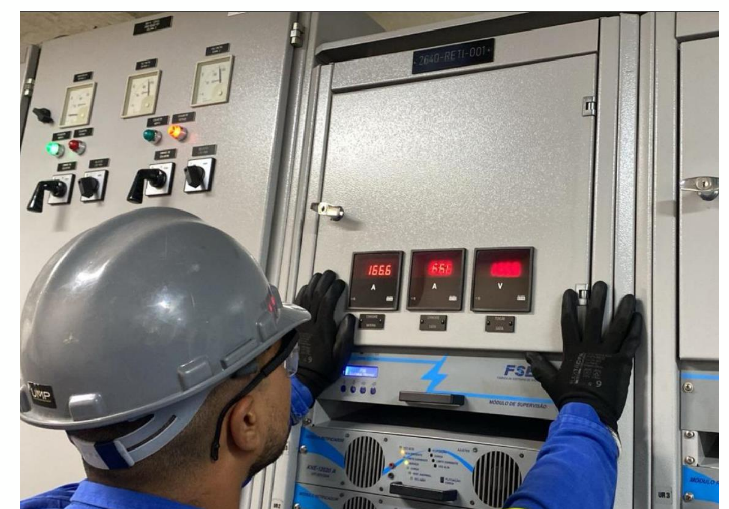
MEDIÇÃO DE TENSÃO PAINEL DE AUTOMAÇÃO DA EBV
