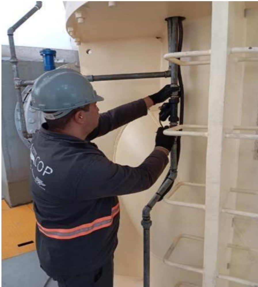
INSPEÇÃO NO SENSOR DE FLUXO DE AGUA DA MOTOBOMBA
