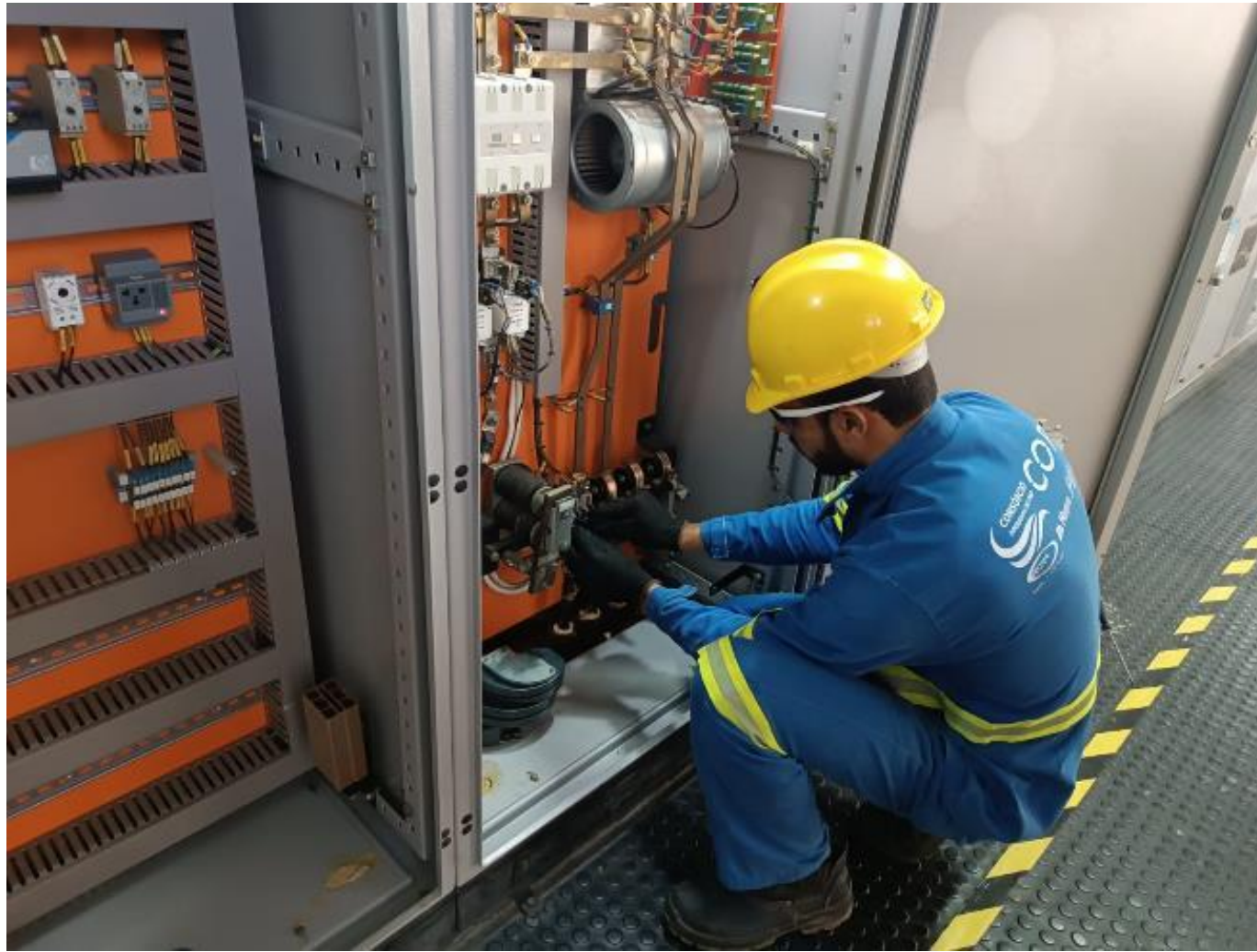
ENSAIO RESISTENCIA DE CONTATO PNEX
