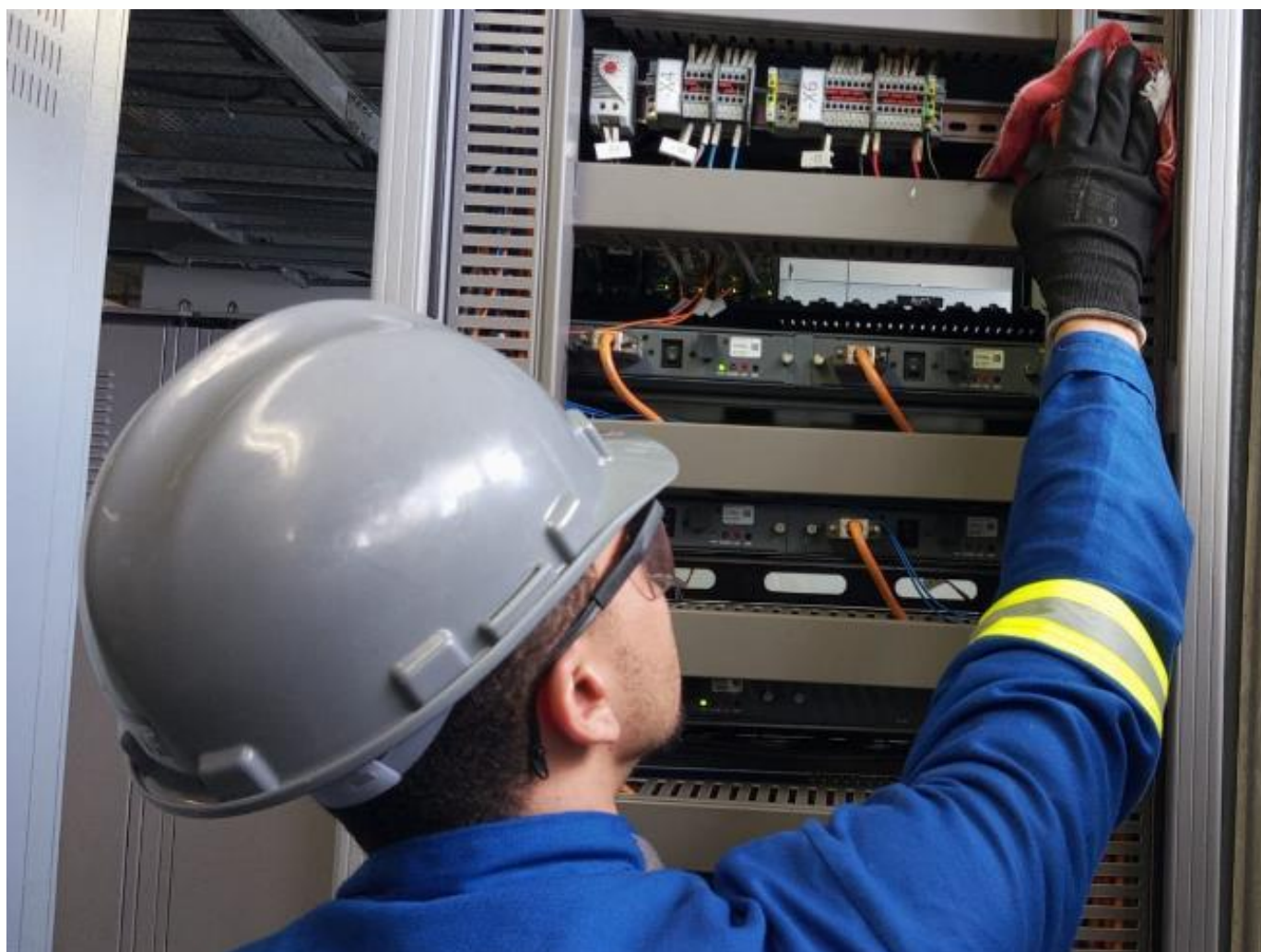
LIMPEZA PAINEL DE TELECOMUNICAÇÃO
