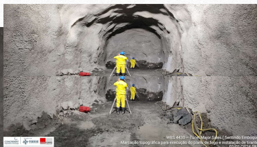
Marcação topográfica e execução de bate choco;
