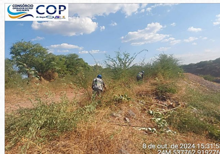
Segmento de Canal( WBS 1234)
