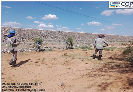
Barragem Terra Nova (WBS 1106)
