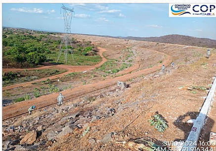
Reservatório Boi I (WBS 1116)
