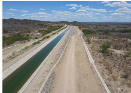
Segmento de Canal C8.5
