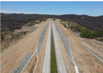
Segmento de Canal C3
