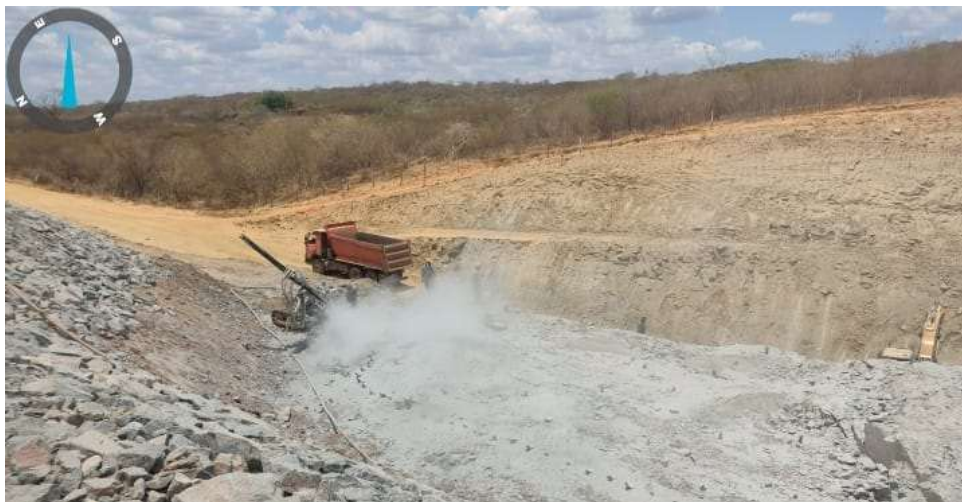
Túnel Major Sales: Perfuração para o rebaixo da bancada
