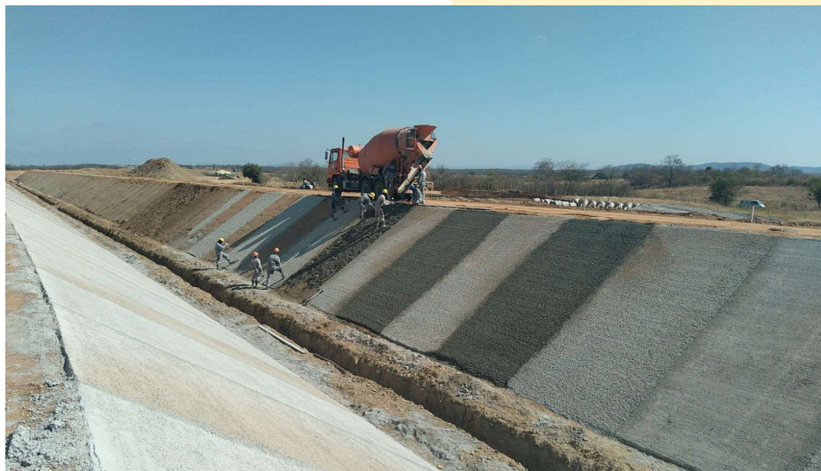
C6B: Execução do concreto poroso
