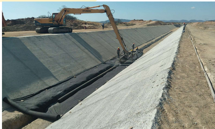
Canal 6B: Execução do dreno de fundo
