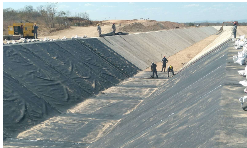
C6B: Execução da geomembrana
