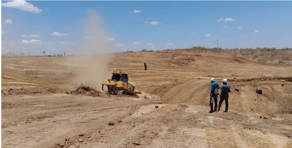
Canal 8: Execução da supressão vegetal
