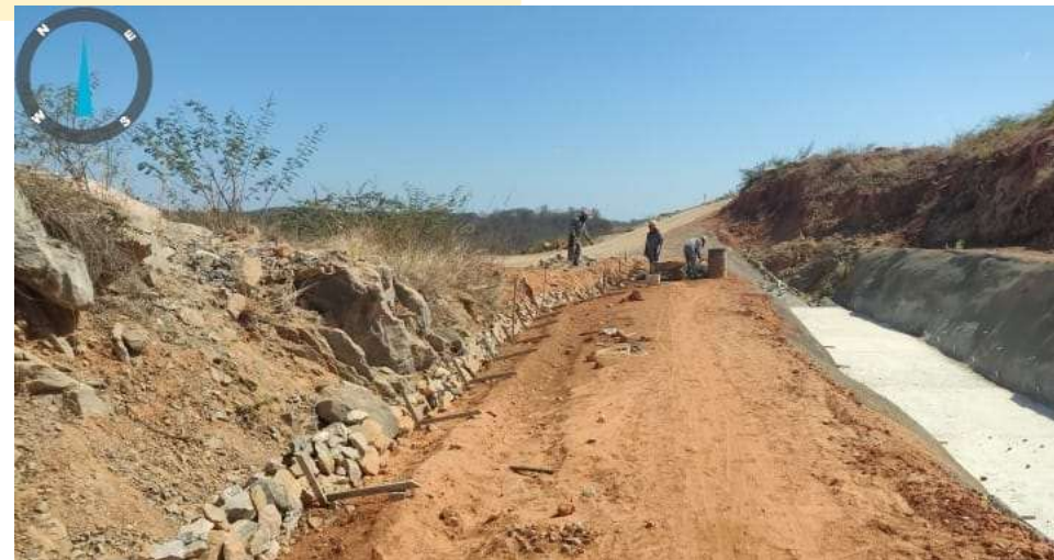
C1: Execução das canaletas
