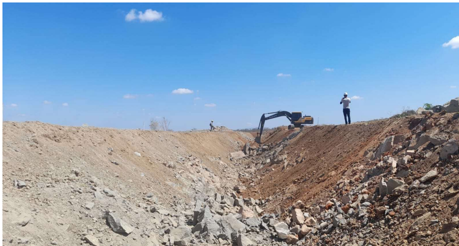
C7B: Execução da regularização da seção hidráulica
