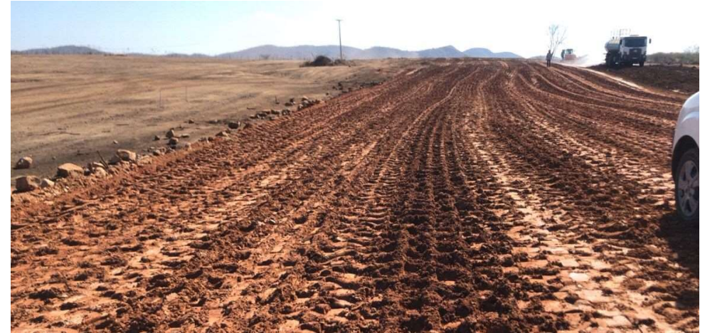
Canal 08: Execução da terraplenagem
