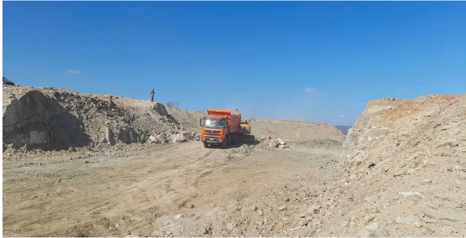
C7B: Execução da terraplenagem (escavação 3ª categoria)
