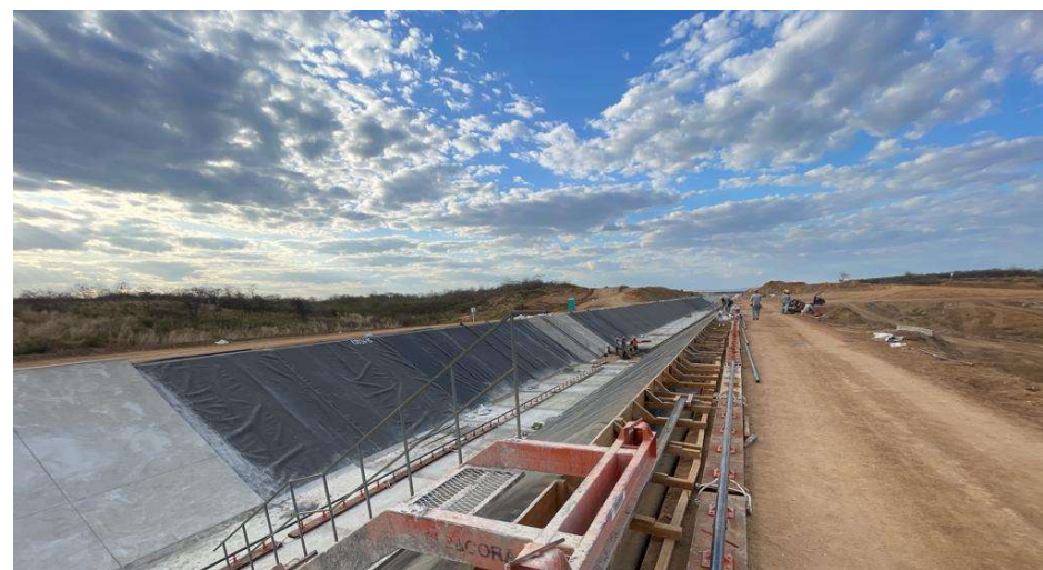
C6B: Concretagem do canal
