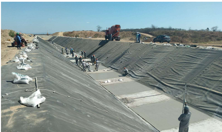
C6B: Execução do concreto na seção hidráulica
