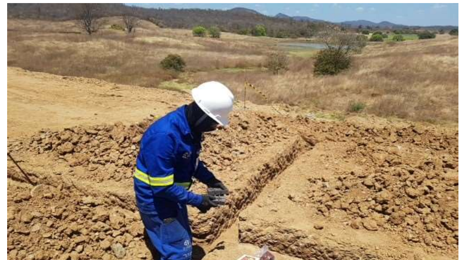
EC Km 30: Execução do aterramento
