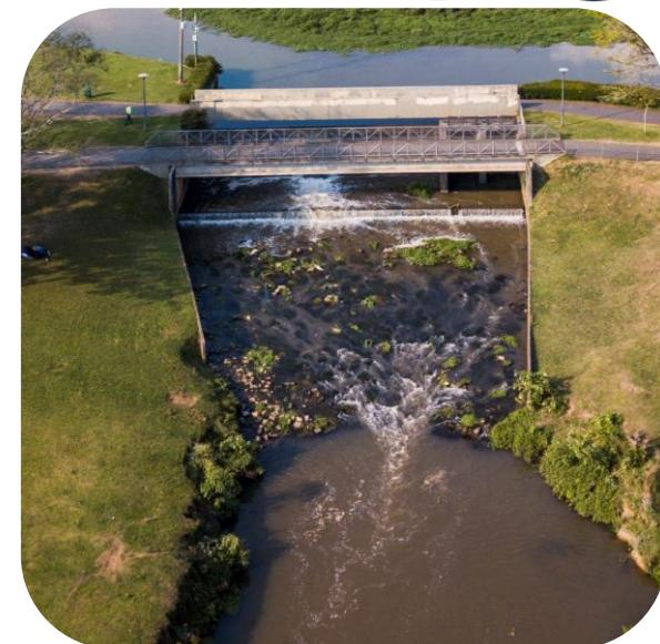
Vertedor com dissipador de energia
