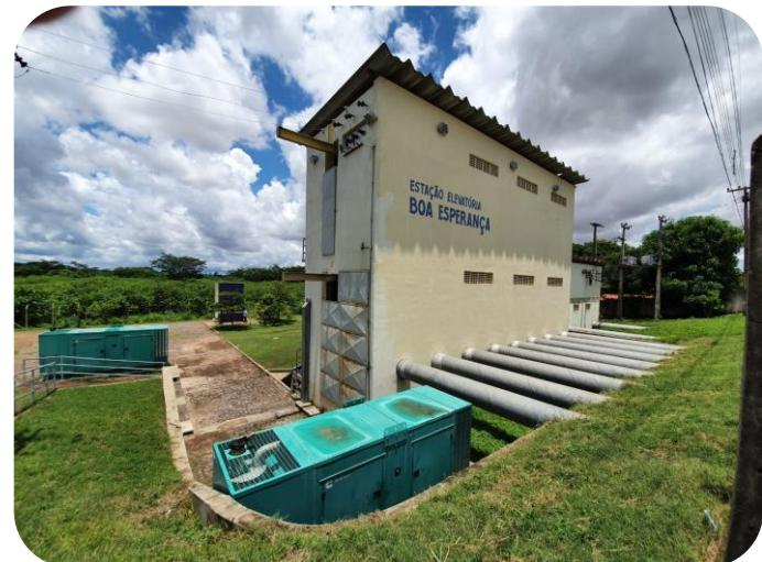
Dique e estação elevatória para o controle de inundação fluvial, Teresina (PI)
