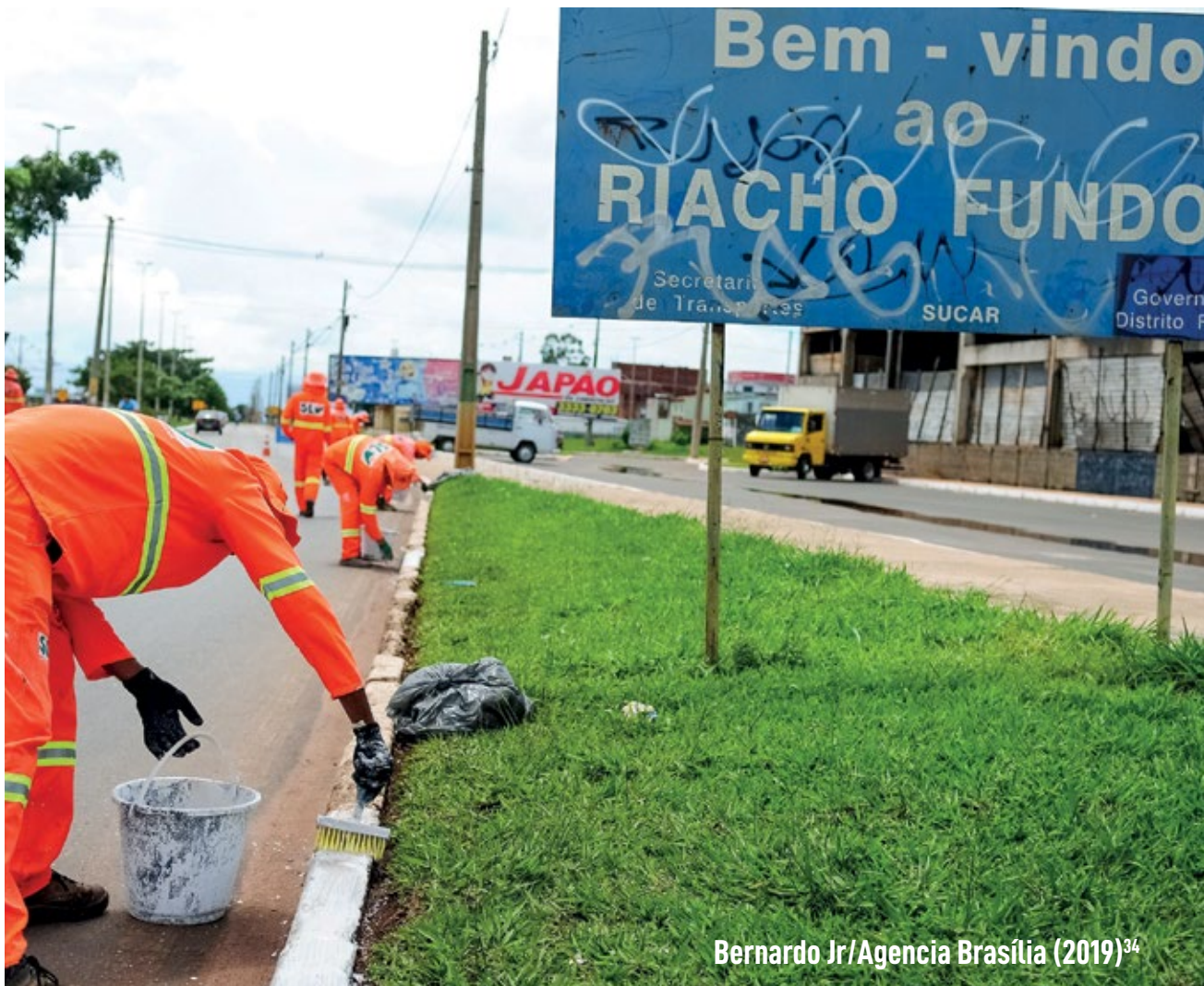
FIGURA 20 – Pintura de meio-fio
