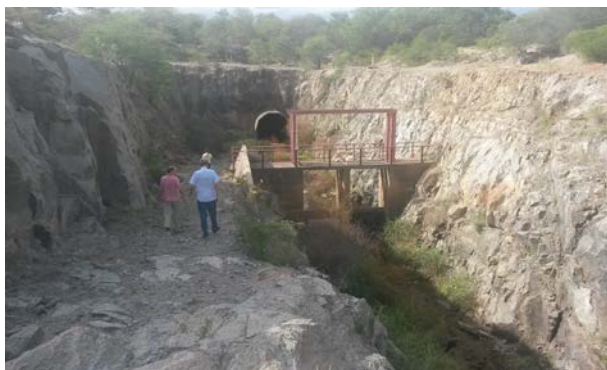
Figura 6 – Canal de interligação entre os reservatórios Estreito e Cova da Mandioca, estrutura de controle e túnel ao fundo
