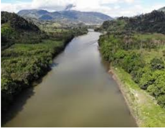
Figura 1 - Controle Hidráulico de Canal
