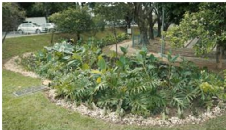
Figura 6. Jardim de chuva implantado na Praça Tancredo Neves, Contagem/MG (Escritório Guajava Arquitetura da Paisagem e Urbanismo, foto: Meridiano Filmes, 2021).
