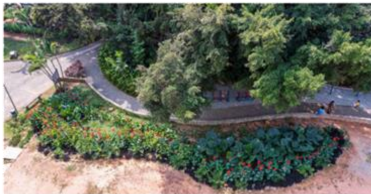
Figura 5. Jardim de chuva em sistema integrado de SbN implantado no Parque Municipal Lago do Riacho, Belo Horizonte/MG (Projeto Escritório Guajava Arquitetura da Paisagem e Urbanismo, foto: Nereu Jr, 2021).
