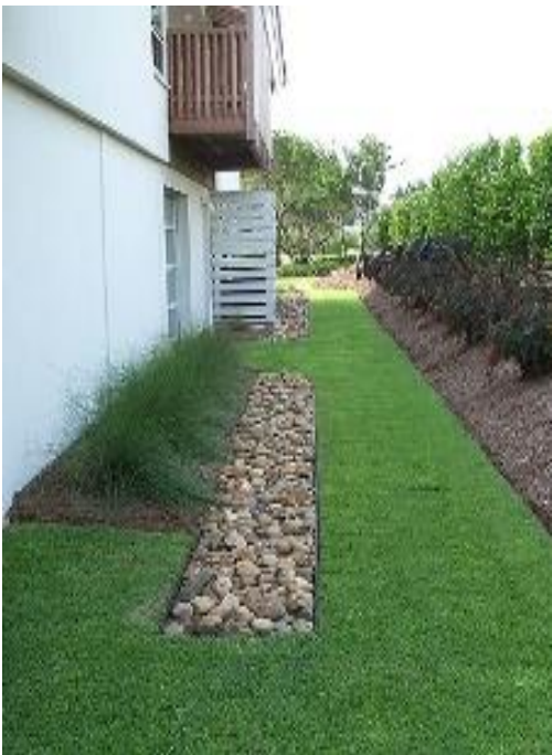
Trincheiras de infiltração
