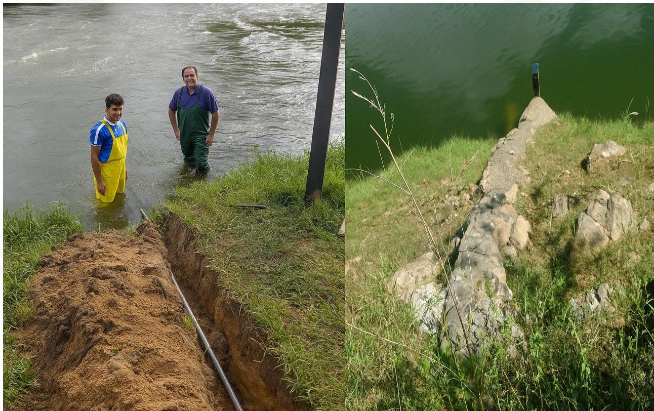
Figura 24 – Detalhe da instalação de sensores de pressão
