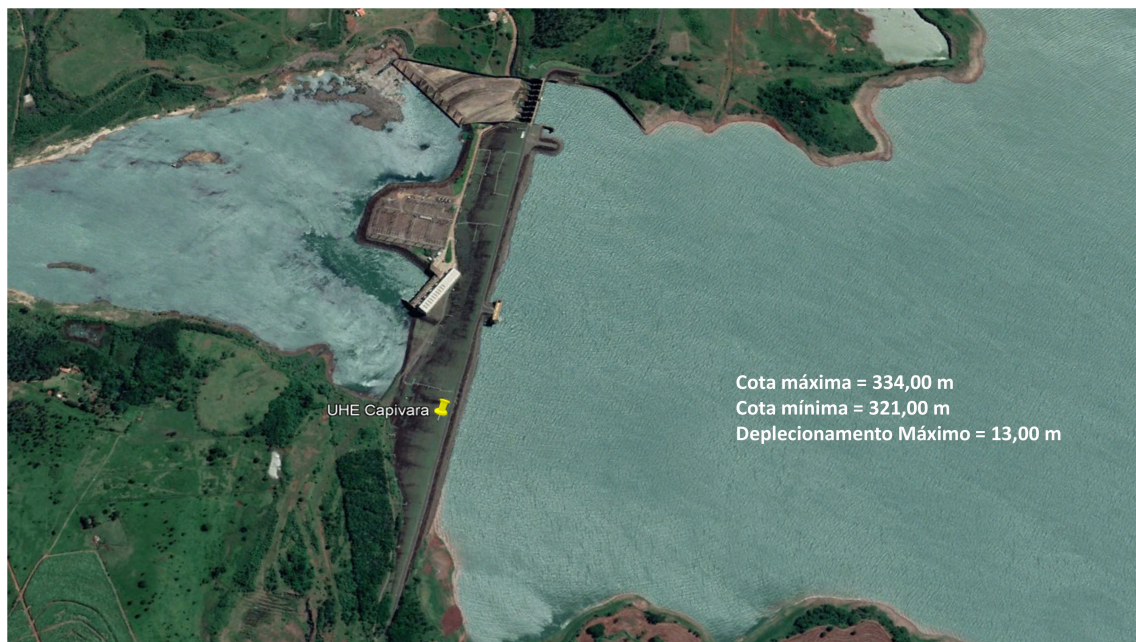
Figura 7 – Barragem Capivara – Rio Paranapanema
