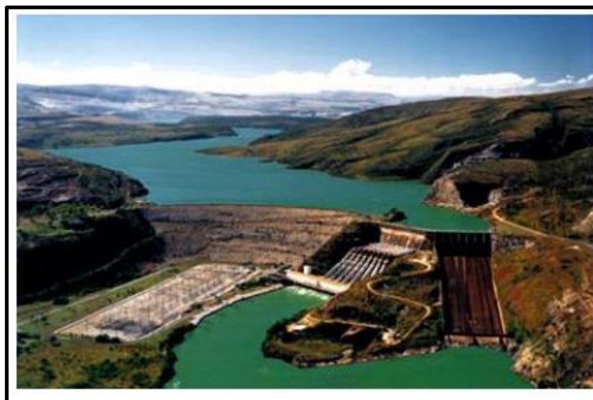
Figura 10 – Imagem aérea da UHE Furnas 9
