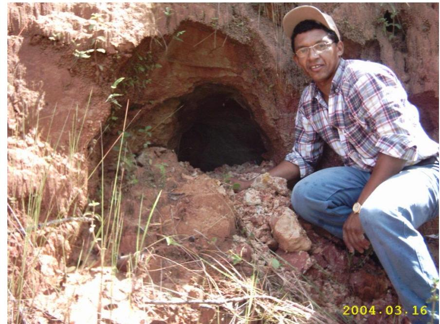
Talude de boçoroca instabilizado por fenômenos de *Piping*, formado por erosão interna
