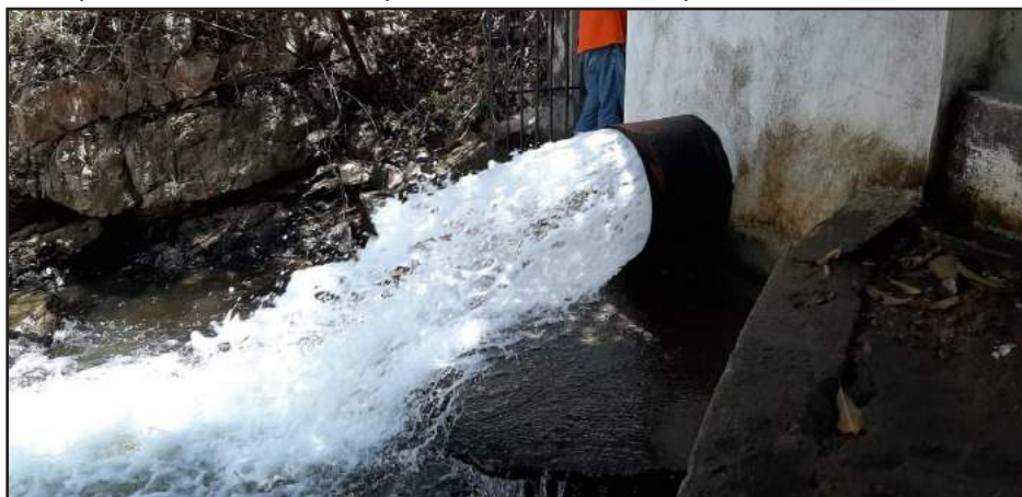
A comporta ficou aberta por trinta dias para um pulso e a liberação foi de aproximadamente 2,68 m³
