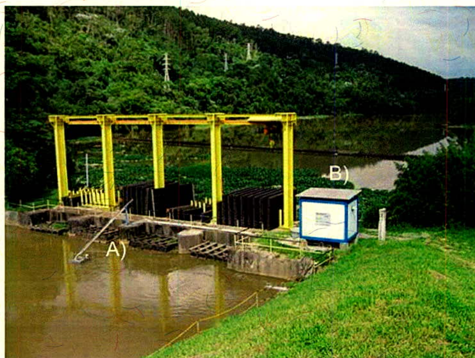
Figura 90. Vista da Estação Automática de Monitoramento Rasgão, localizada no rio Tietê em Pirapora do Bom Jesus – SP: (A) Vista da estrutura metálica flutuante que suporta a bomba de recalque; (B) Container (Foto: Luis Altivo Carvalho Alvim).
