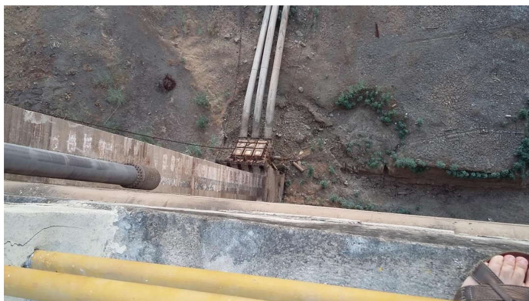
Figura 7 – Dupla adução para descarga – sifão e descarga de fundo – vista montante
