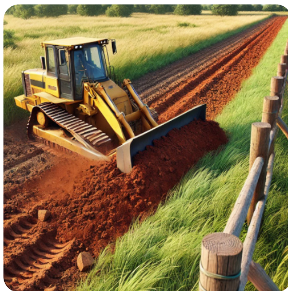
Figura 12 - Representação da criação de um aceiro na divisa da propriedade, deixando uma faixa livre de material combustível para prevenção de incêndios.
