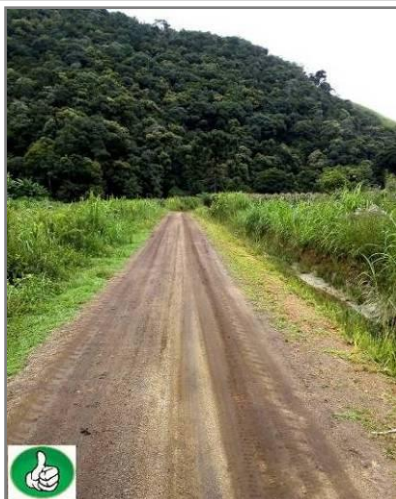
Plataforma e sarjetas com alta sustentabilidade ambiental
