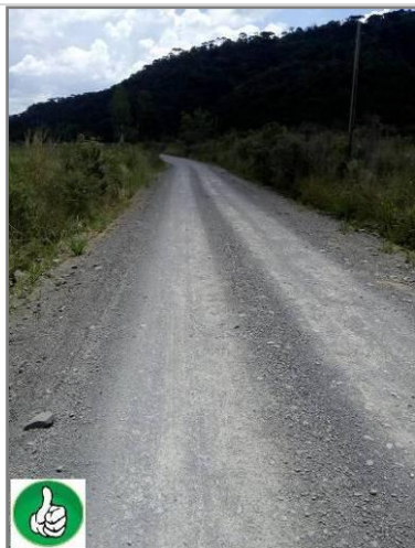
Sarjeta funcional contribui para manter plataforma
