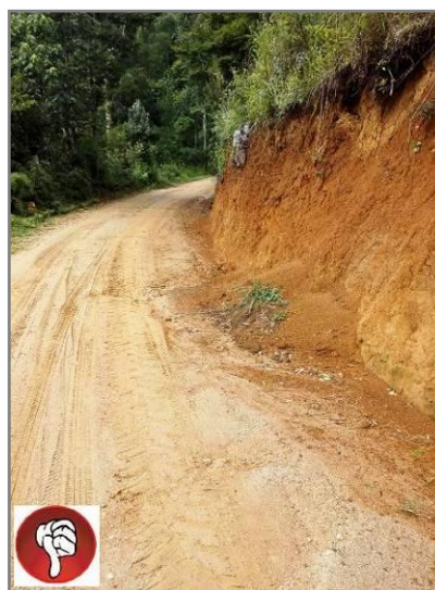
Talude não protegido com baixa sustentabilidade ambiental
