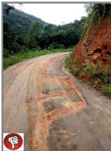
Plataforma e sarjetas com baixa sustentabilidade ambiental
