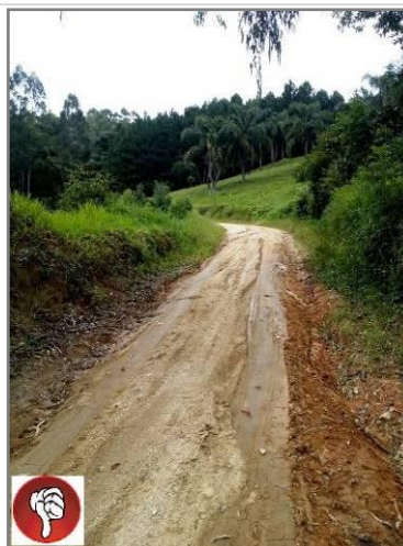
Sarjeta não funcional contribui para degradar plataforma
