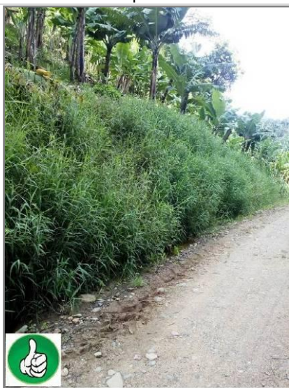
Talude protegido com alta sustentabilidade ambiental
