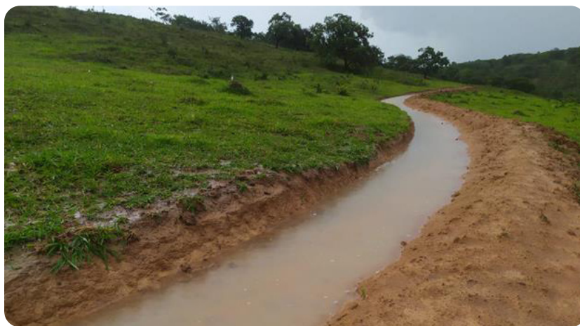
Foto 19 - Terraço Tipo Mangum Heytor Marcos Silva Pimenta
