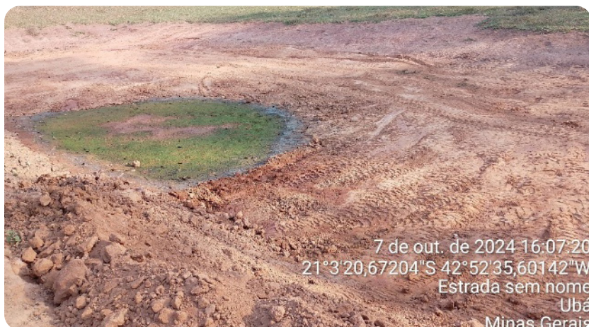
Foto 18 - Barraginha em manutenção – Projeto de PSA – Ubá/MG. Lauro Bassi
