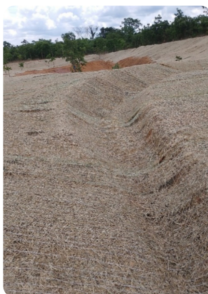
Foto 54 - Terraços construído. Lauro Bassi
