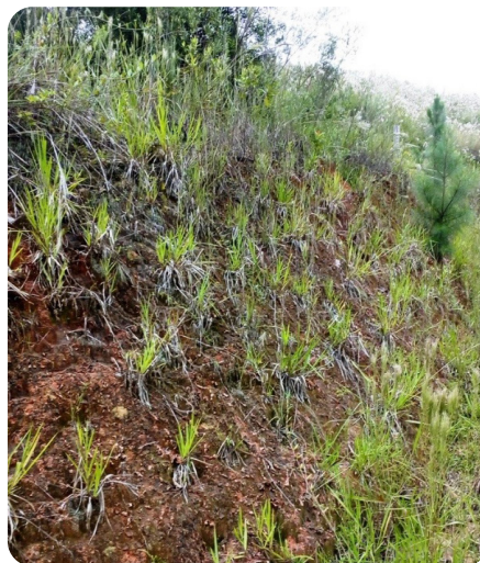
Foto 63 - Talude com plantio de vegetação Lauro Bassi
