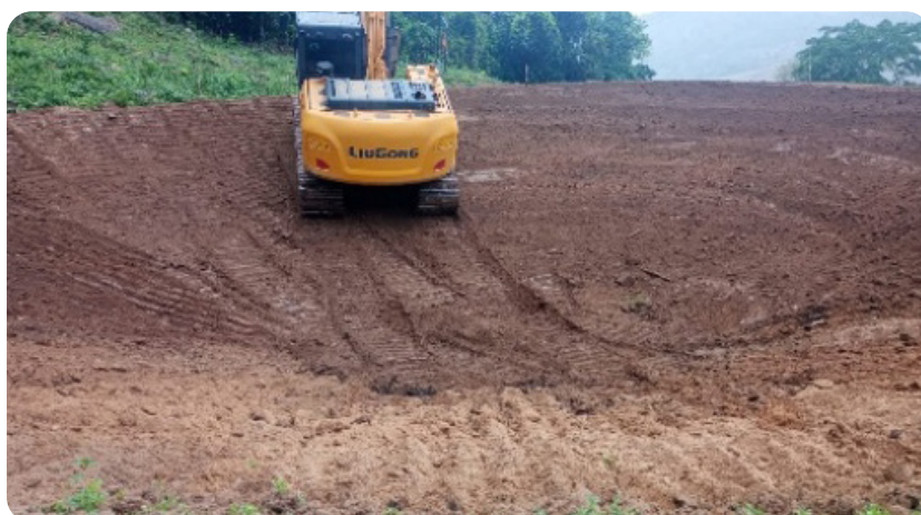
Foto 15 – Imagem demonstrativa de escavação da barragem. Márcio Menon
