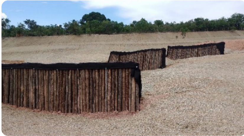
Foto 56 - Paliçadas instaladas. Lauro Bassi
