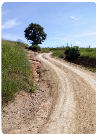
Foto 73 - Erosão na valeta (sarjeta) Lauro Bassi
