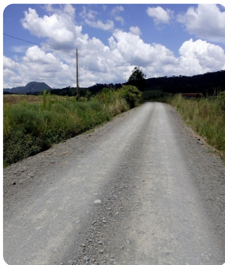
Foto 65 - Plataforma com abaulamento. Lauro Bassi
