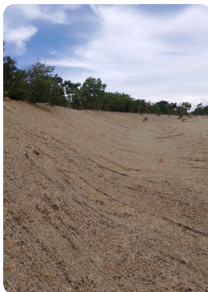
Foto 53 - Talude reconformado. Lauro Bassi
