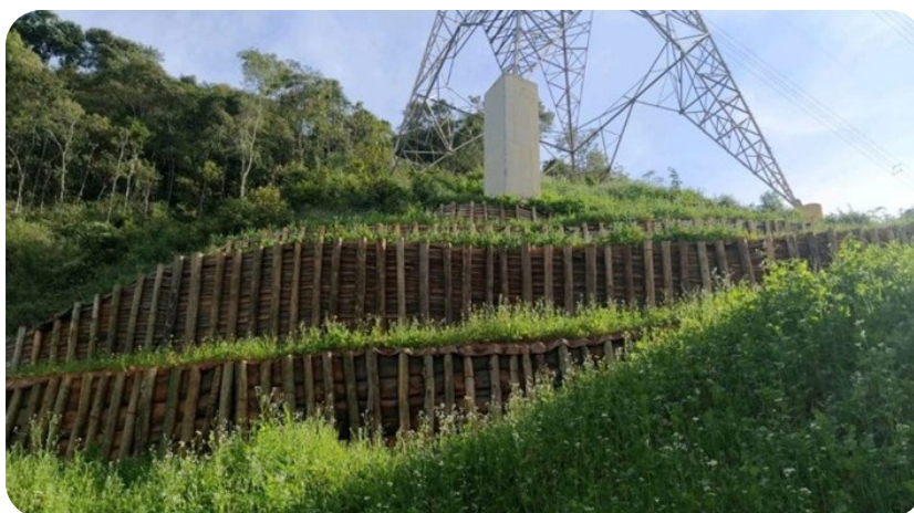
Foto 49 - Paliçadas de eucaliptos tratados para contenção de encosta, com plantio de mix de sementes para estabilização. Terra Green Bioengenharia 19
