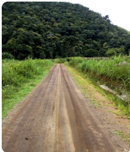
Foto 64 - Plataforma com abaulamento. Lauro Bassi
