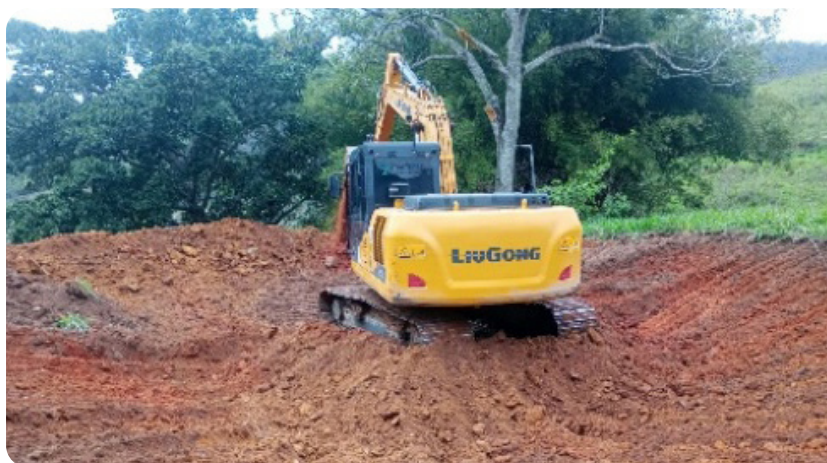
Foto 14 – Imagem demonstrativa de delimitação e início da construção da barragem. Márcio Menon
