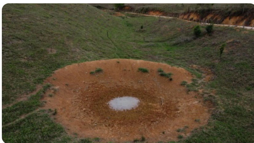
Foto 4 - Barraginha circular contendo a enxurrada proveniente de estrada rural vicinal. Márcio Menon
