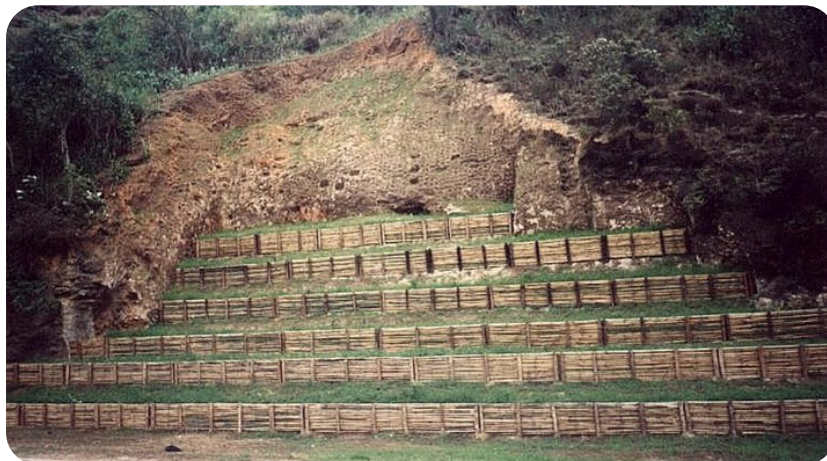
Foto 48 - Paliçadas de Eucaliptos Tratados para contenção de encosta. Geocities 18
