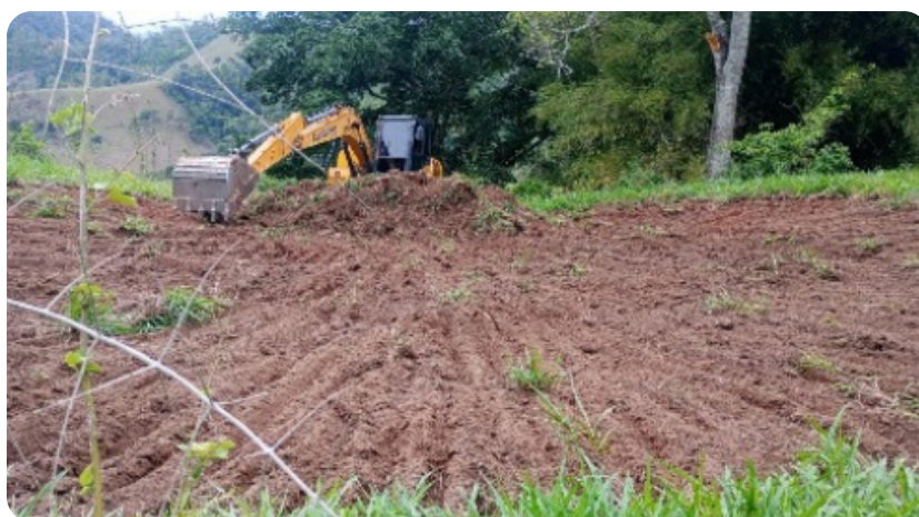
Foto 13 – Imagem demonstrativa de ajuntamento do solo superficial em local de futura barraginha. Márcio Menon
