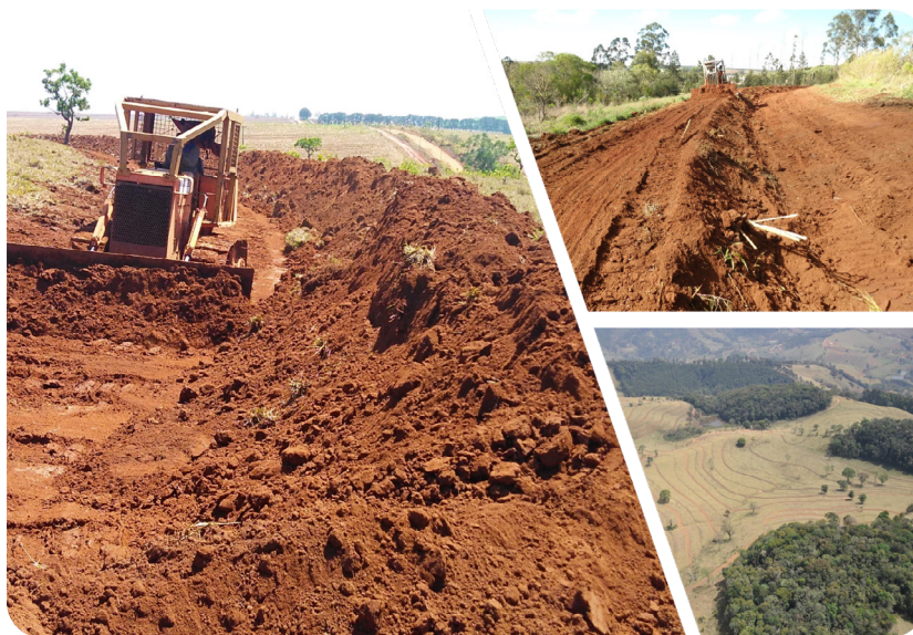
Foto 33 - Construção de terraço com trator de esteiras. José Cezar Zoccal.
