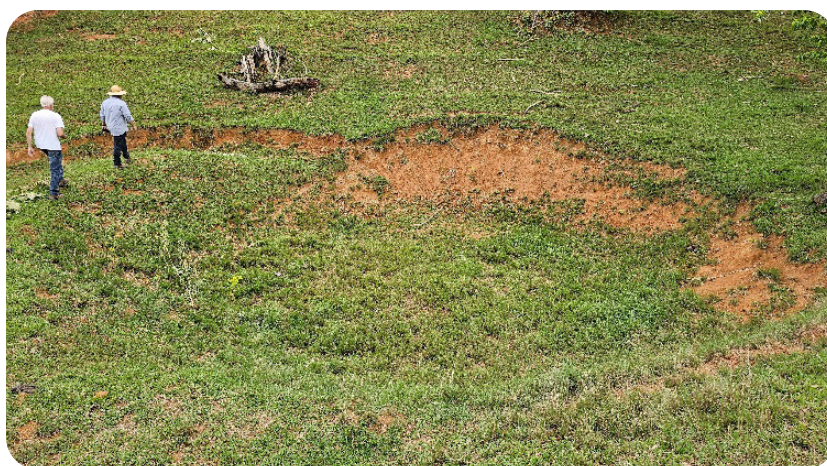
Foto 1 - Barraginha com detalhe do extravasor ou "ladrão" Lucyan V. Listo/Projeto Barraginhas
