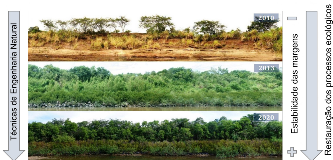
Figura 21 - Evolução temporal de uma obra de engenharia natural aplicada no Rio Pardiniho, Santa Cruz do Sul-RS Fonte: Adaptado de Kettenhuber et al. (2023)
