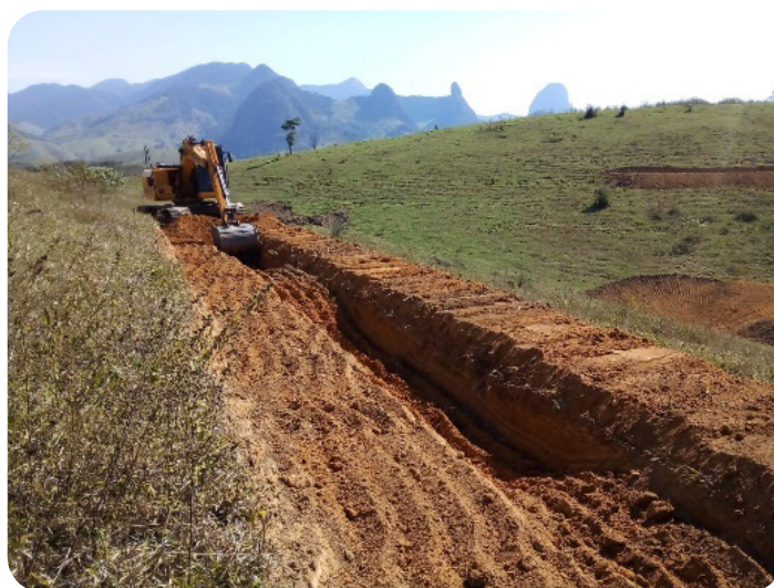
Foto 5 – Execução de terraceamento com cochinho (ES) Marcio Menon / Banco de Imagens ANA
