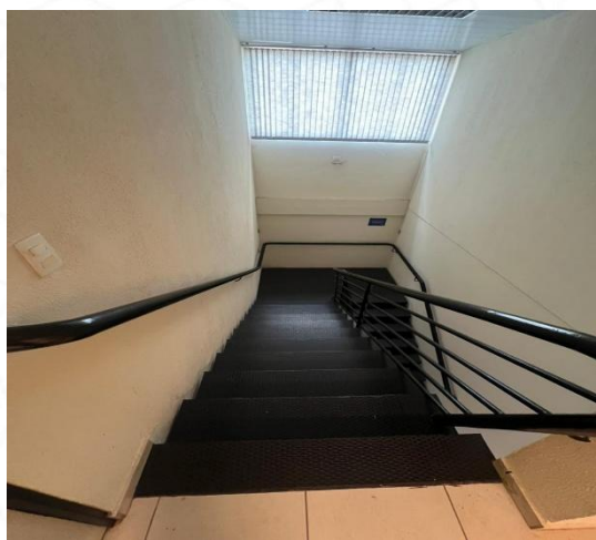
Foto 16: 1º Pavimento – Escada
